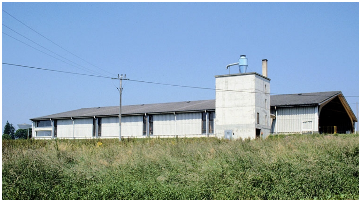
Façade latérale droite et silo à poussières vus de l'est. 39, Orchamps
