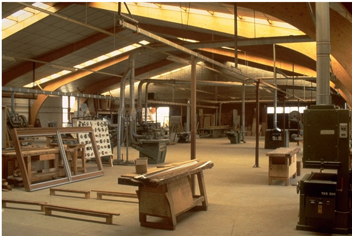
Intérieur de l'atelier de fabrication.
