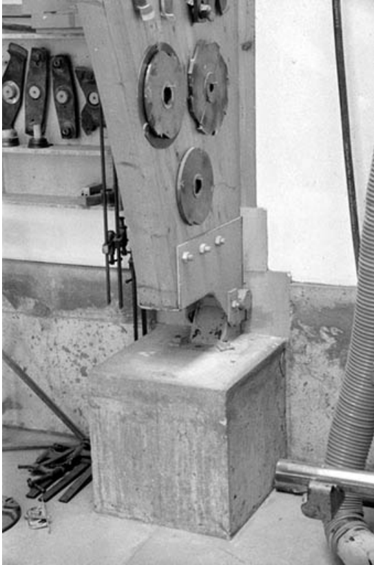
Support d'une ferme de la charpente. 39, Orchamps
