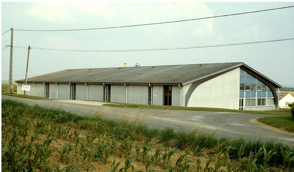
Façades antérieure et latérale gauche vues de l'ouest.
