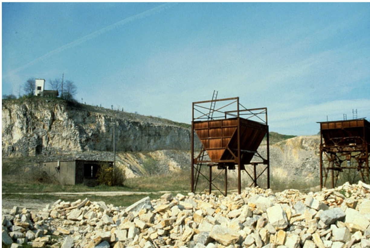
Transformateur, bureau et poste de chargement.
