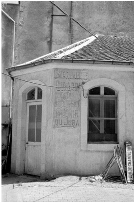
Pan coupé de l'atelier de fabrication et publicité peinte.
