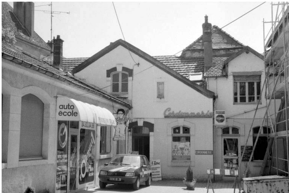
Façade antérieure du bureau.
