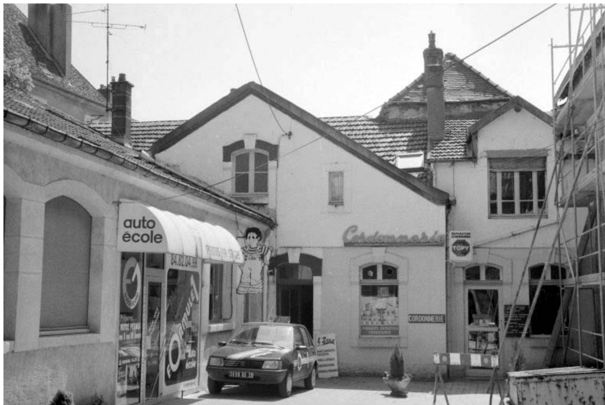
Façade antérieure du bureau.
