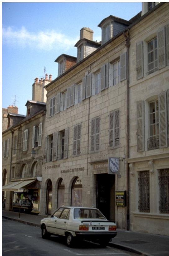
Façade antérieure de la maison, vue de trois quarts droit.
