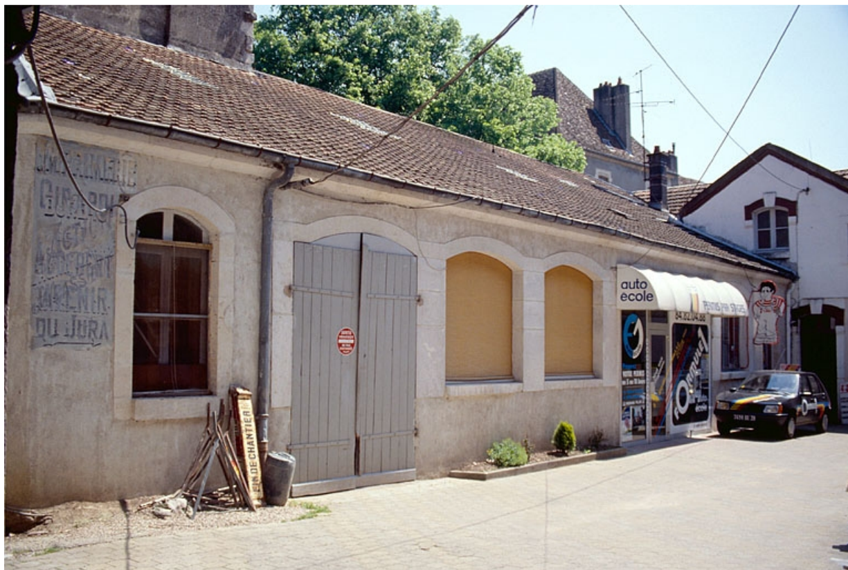
Façade antérieure de l'atelier de fabrication, vue de trois quarts gauche.
