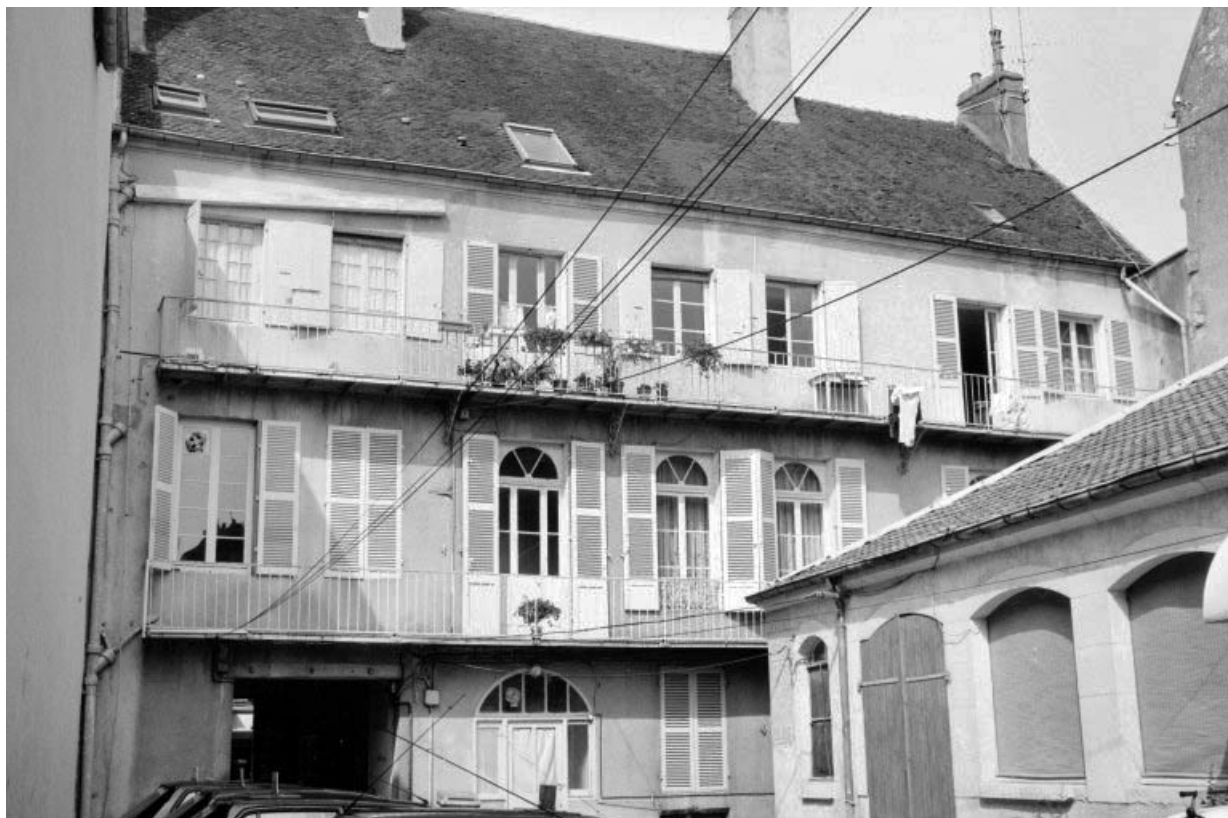
Façade postérieure de la maison.
