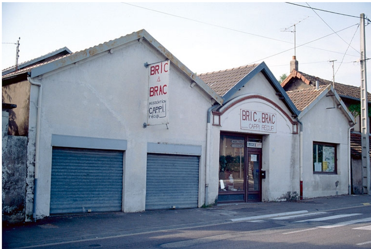
Façade antérieure de la seconde unité, vue de trois quarts gauche.
