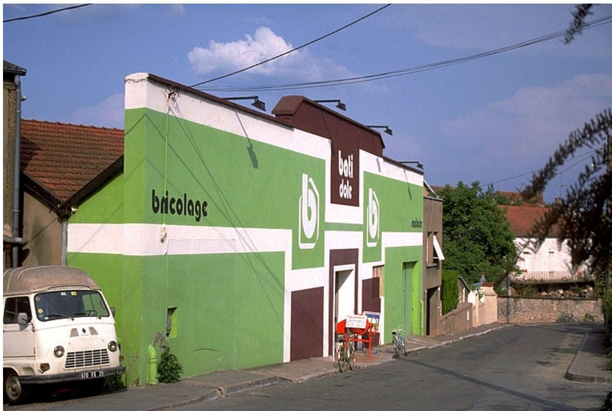
Façade antérieure de la première unité, vue de trois quarts gauche. 39, Dole, 5 rue Maurice Pagnon
