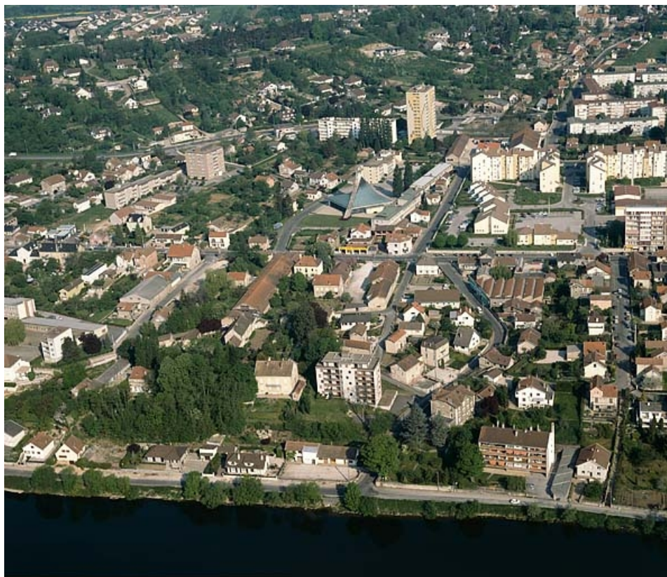
Vue d'ensemble depuis le sud-est, photographie aérienne.
