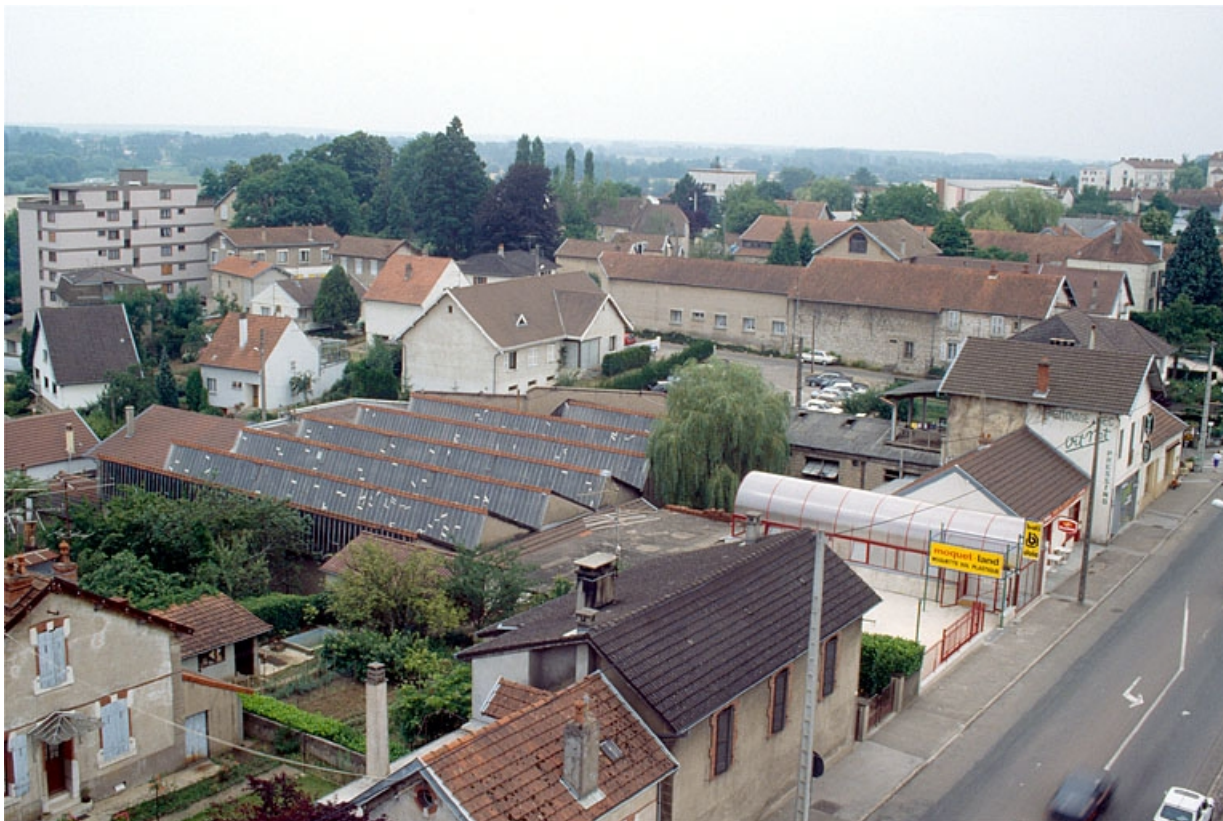
Vue plongeante sur les toitures de la première unité, depuis le nord.
