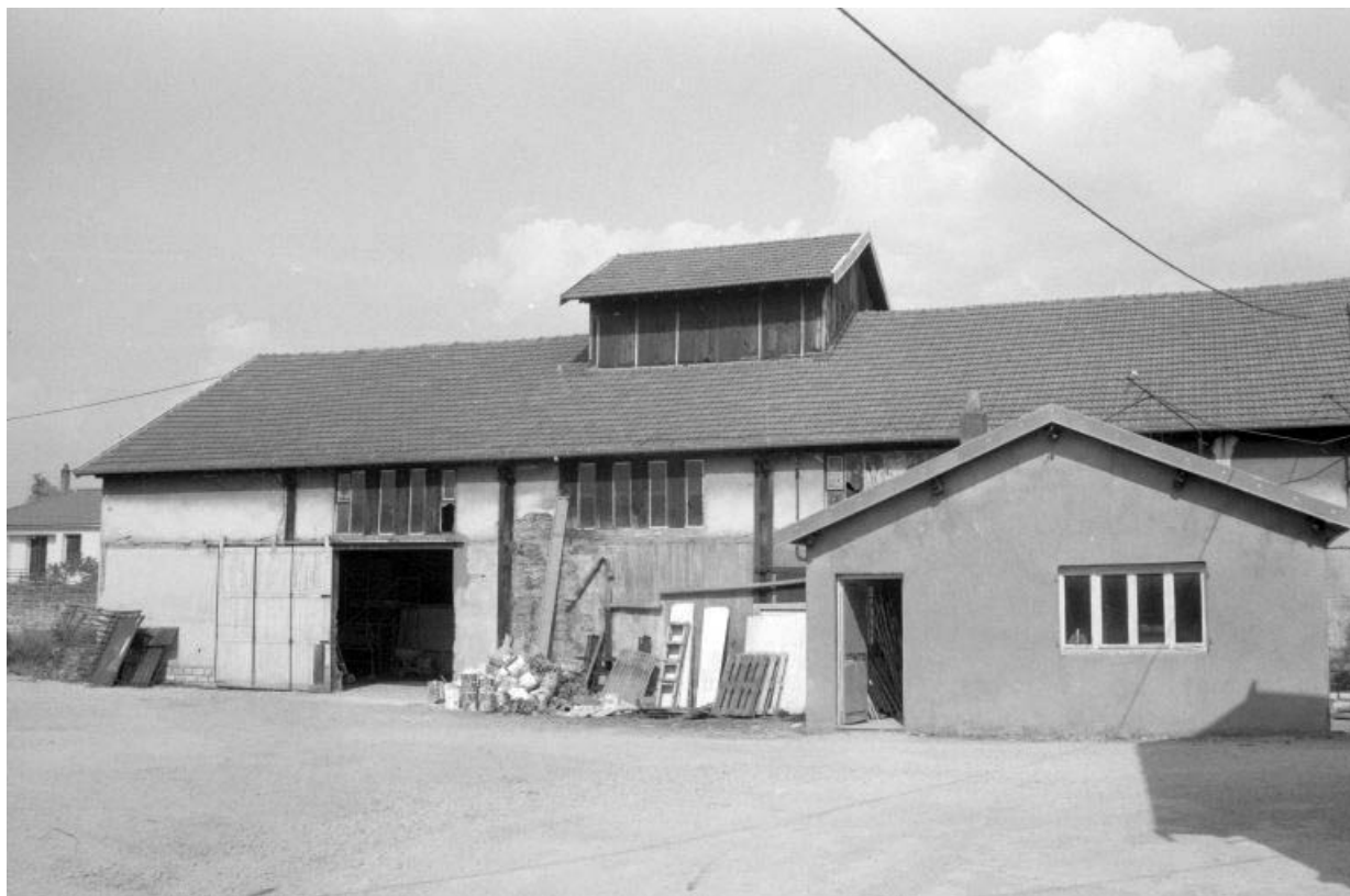
Façade antérieure de l'atelier de fabrication et du bureau (G).
