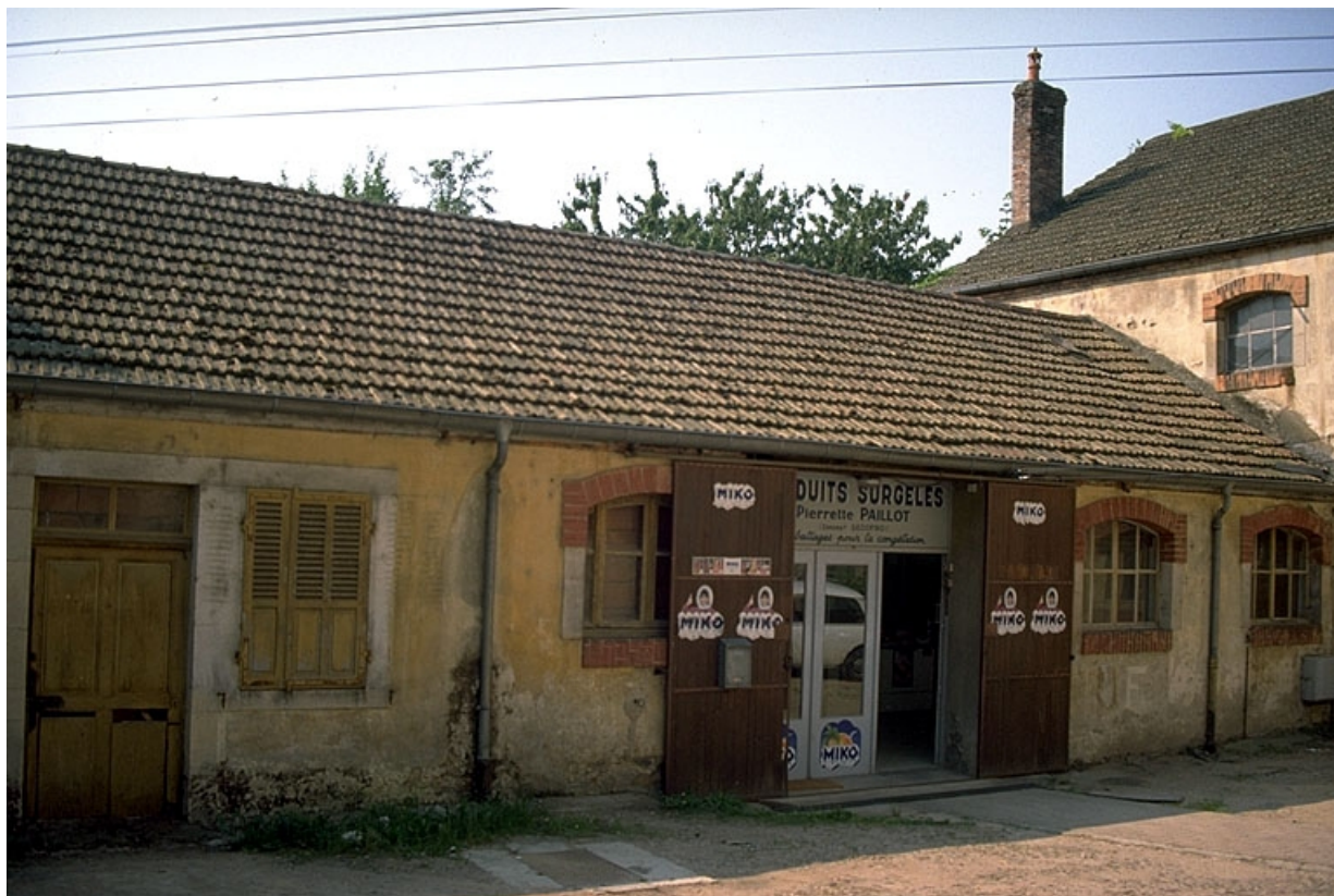
Façade antérieure du corps de bâtiment principal, vue de trois quarts gauche. 39, Dole, 19 rue Marcel Aymé
