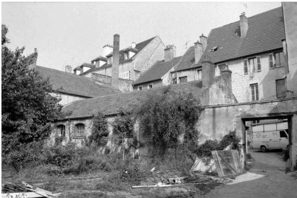
Façade postérieure du corps de bâtiment principal, depuis le jardin du couvent. 39, Dole, 19 rue Marcel Aymé
