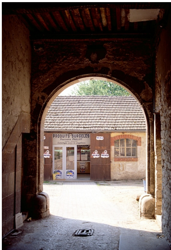
Façade antérieure du corps de bâtiment principal, depuis le porche d'entrée. 39, Dole, 19 rue Marcel Aymé
