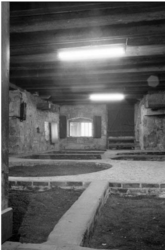
Etage de soubassement : fosses dans la première pièce.
