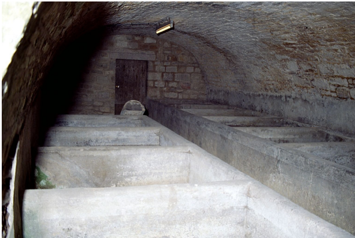
Etage de soubassement : cuves dans la troisième pièce.
