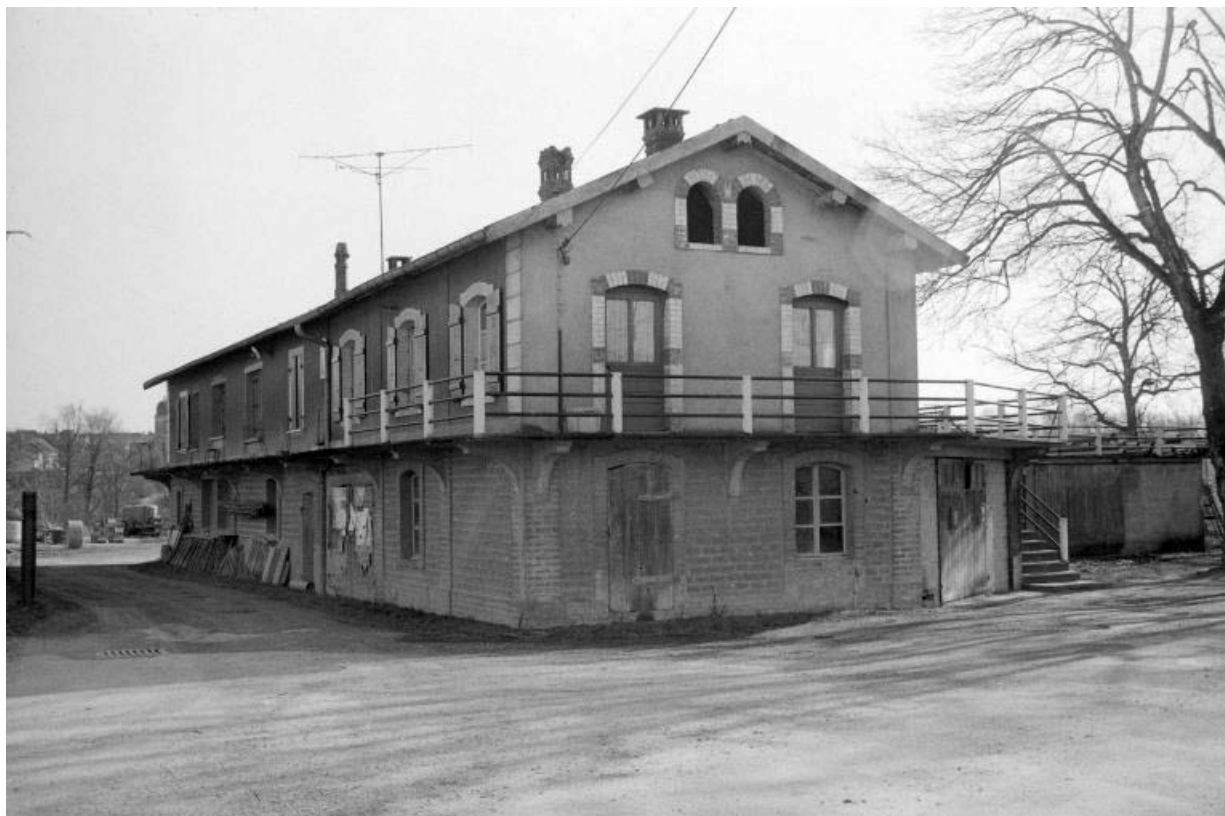
Façades antérieure et latérale gauche vues du nord.
