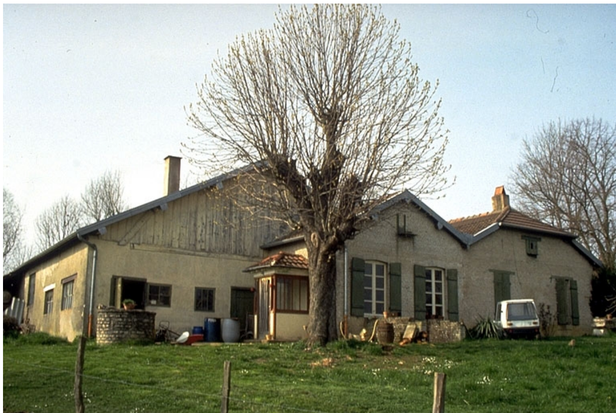
Vue d'ensemble depuis l'ouest. A droite l'habitation, à gauche l'atelier de réparation. 39, Ranchot 1ère briqueterie
