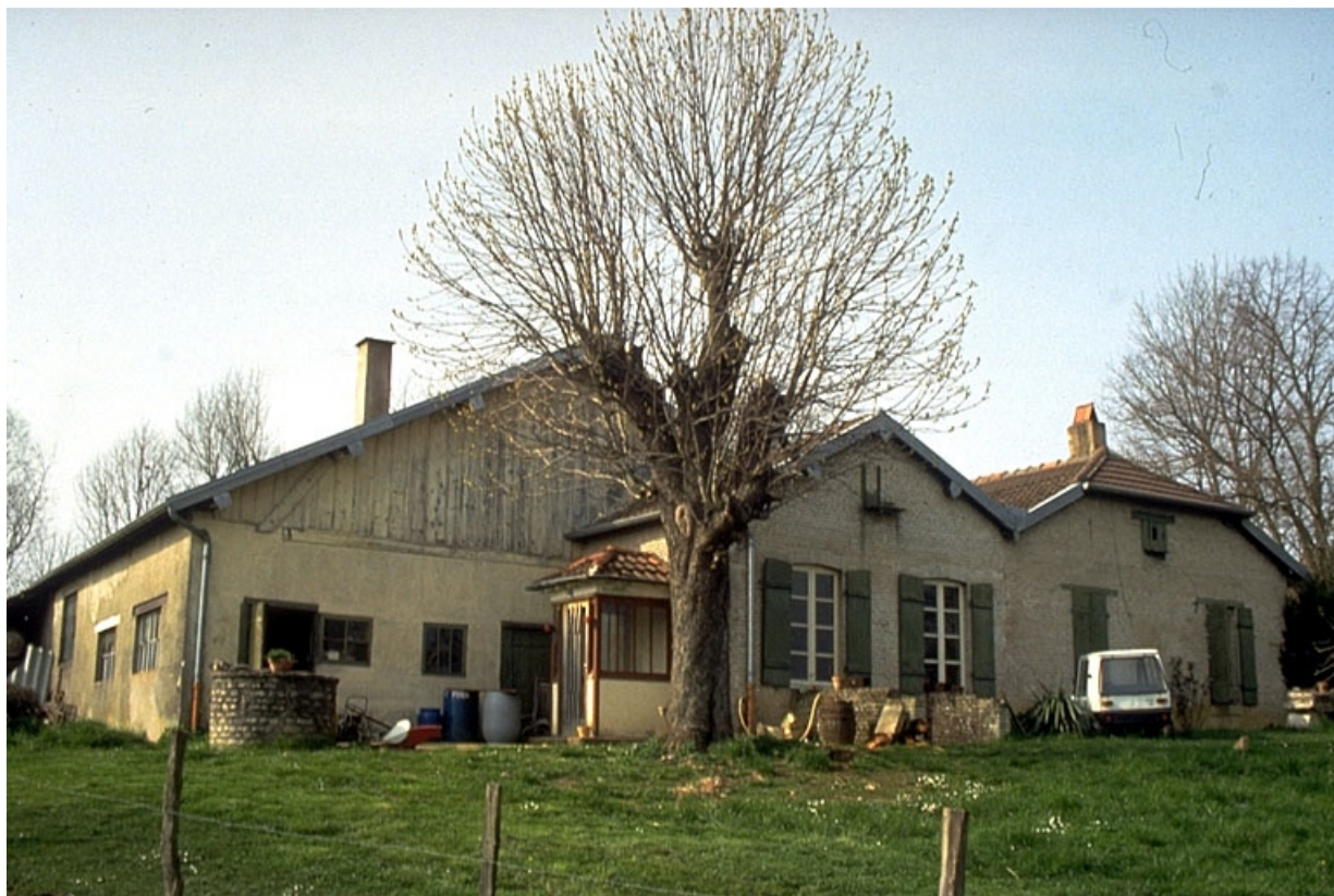
Vue d'ensemble depuis l'ouest. A droite l'habitation, à gauche l'atelier de réparation. 39, Ranchot 1ère briqueterie
