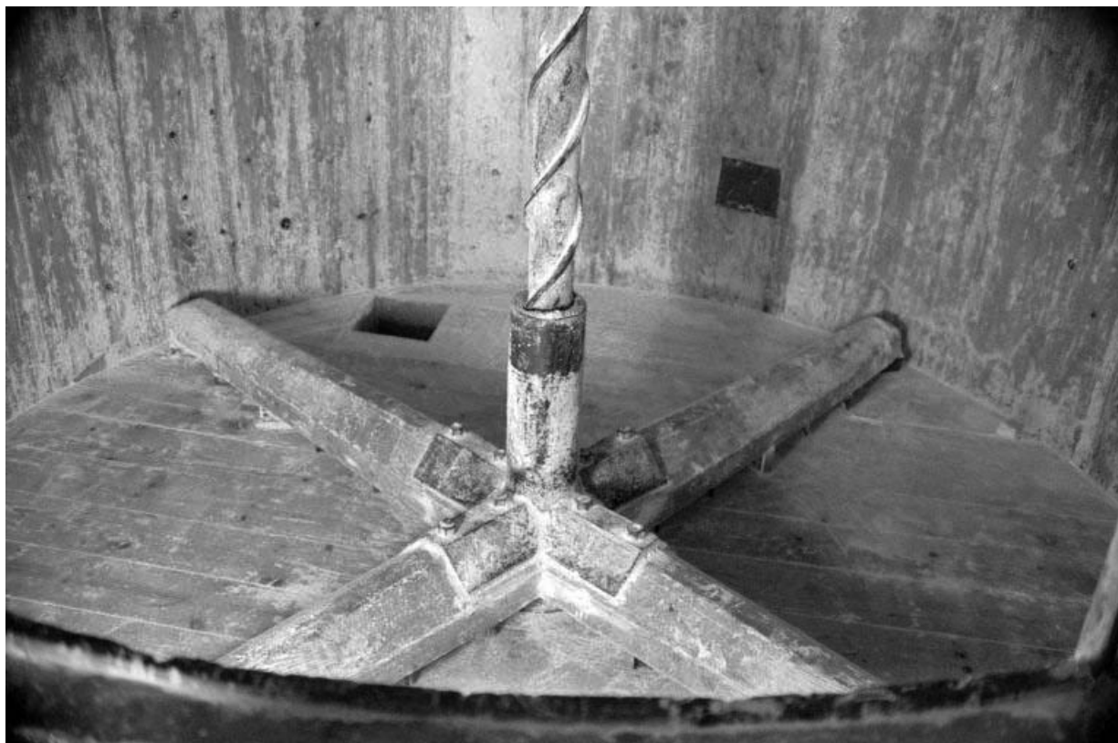
Intérieur : étage, salle de la bluterie, pales du mélangeur à farines.
