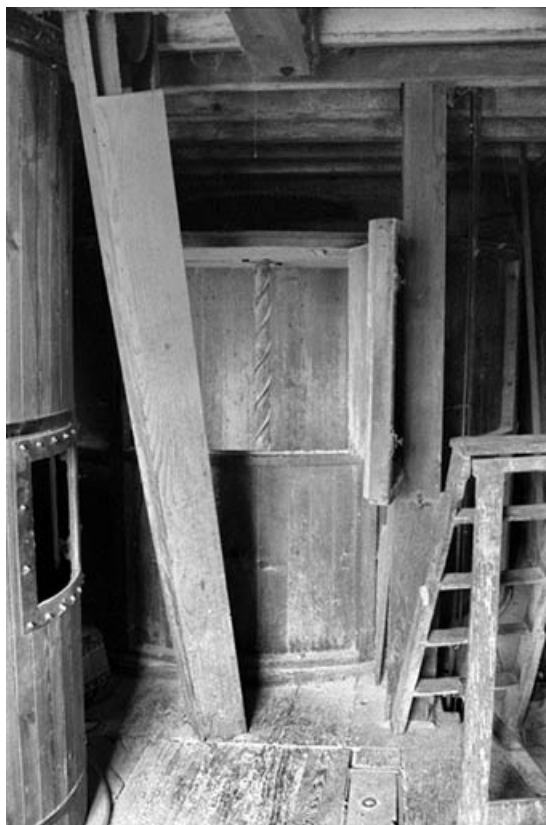
Intérieur : étage, salle de la bluterie, mélangeur à farines.
