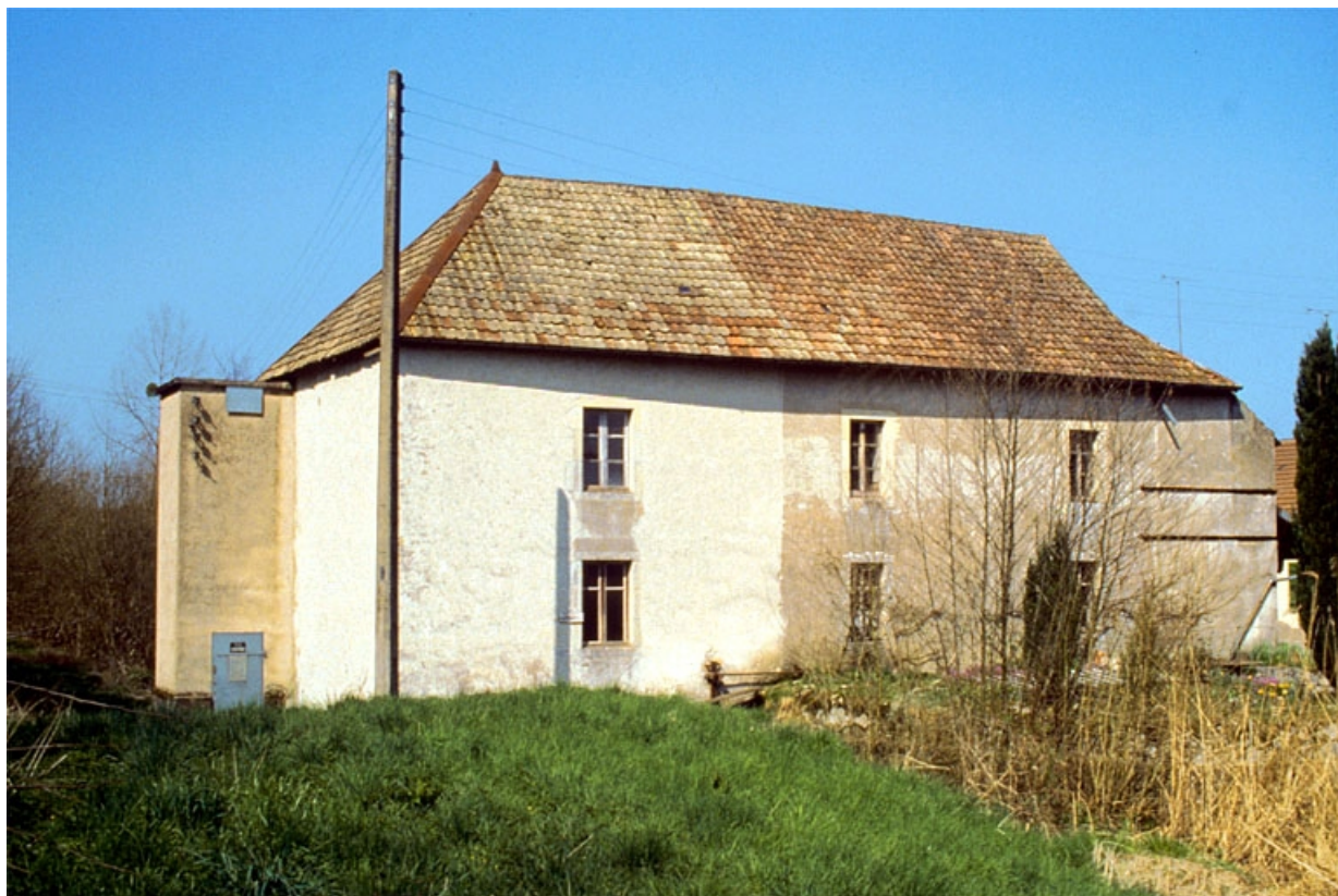
Façade latérale gauche, depuis le sud.
