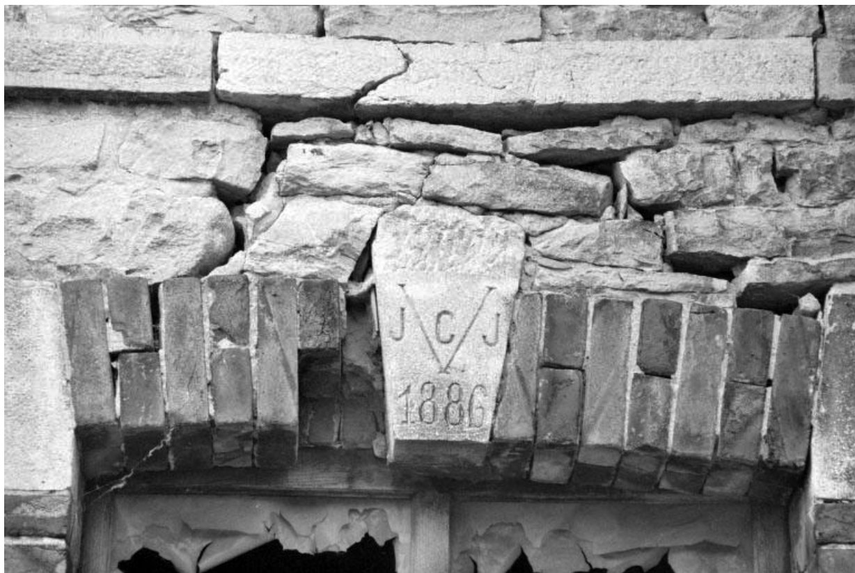
Remise, détail : clef de l'arc de la porte d'entrée.
