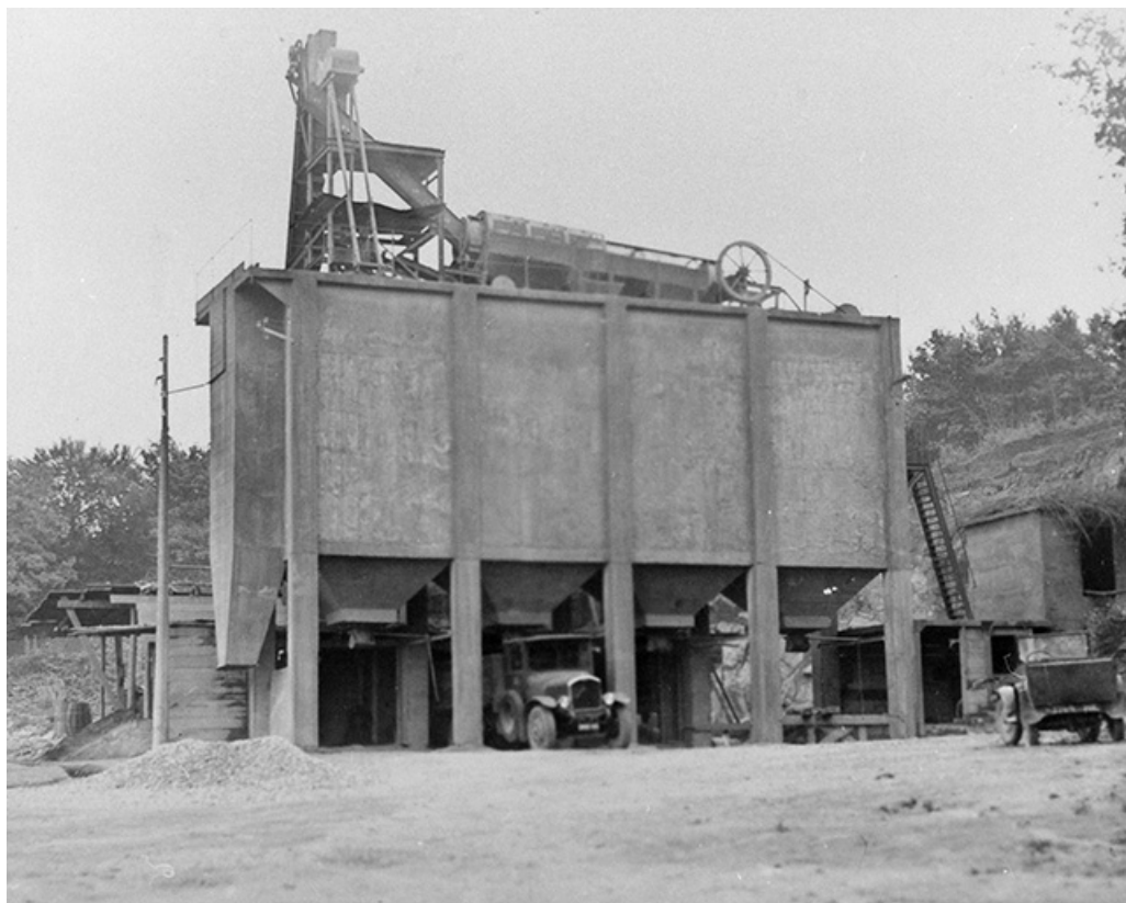
Poste de concassage (C) vu de l'ouest.
