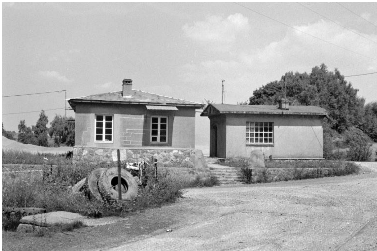
Bureau (A) et bâtiment de la bascule (B), vus de l'ouest.
