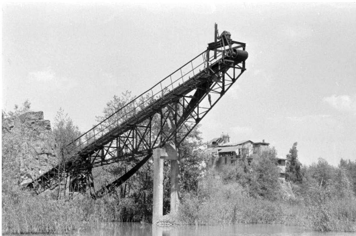
Anciennes installations vues de l'ouest : le transporteur.
