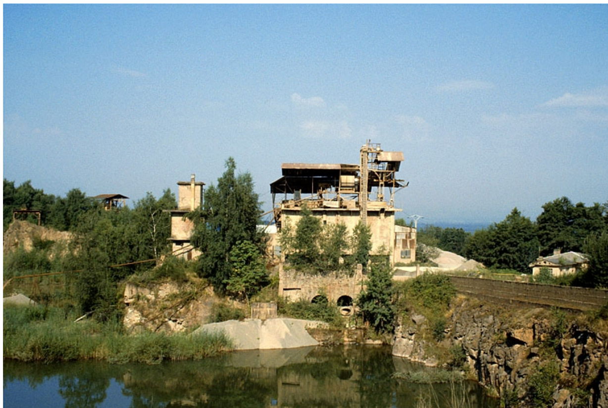
Vue d'ensemble, depuis l'est. Etang au premier plan, poste de lavage (C) au centre, bureau (A) à droite, anciennes installations à gauche.
