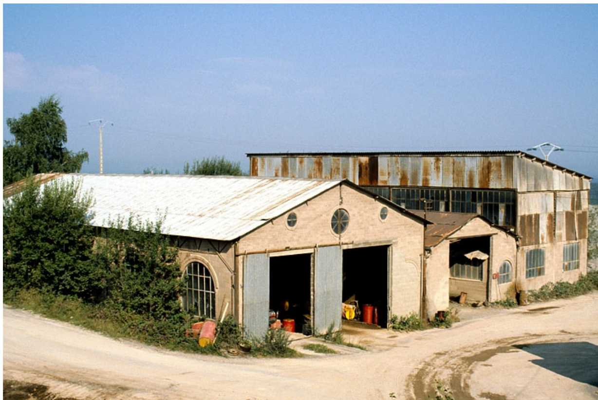
Hangar (G) vu du sud-est.
