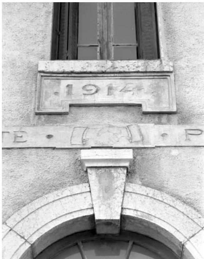
Façade antérieure : date et symbole sur l'avant-corps central.
