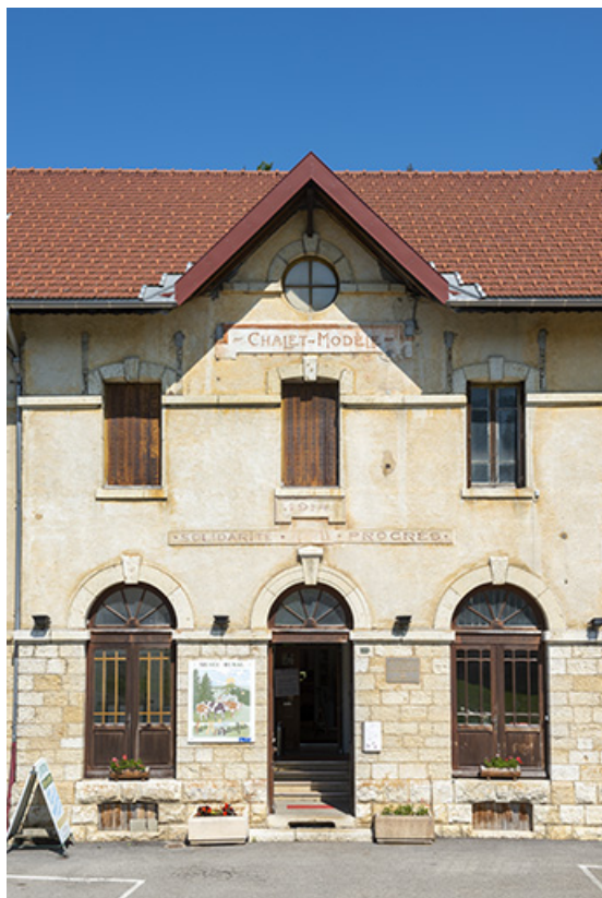
Partie centrale de la façade antérieure.
