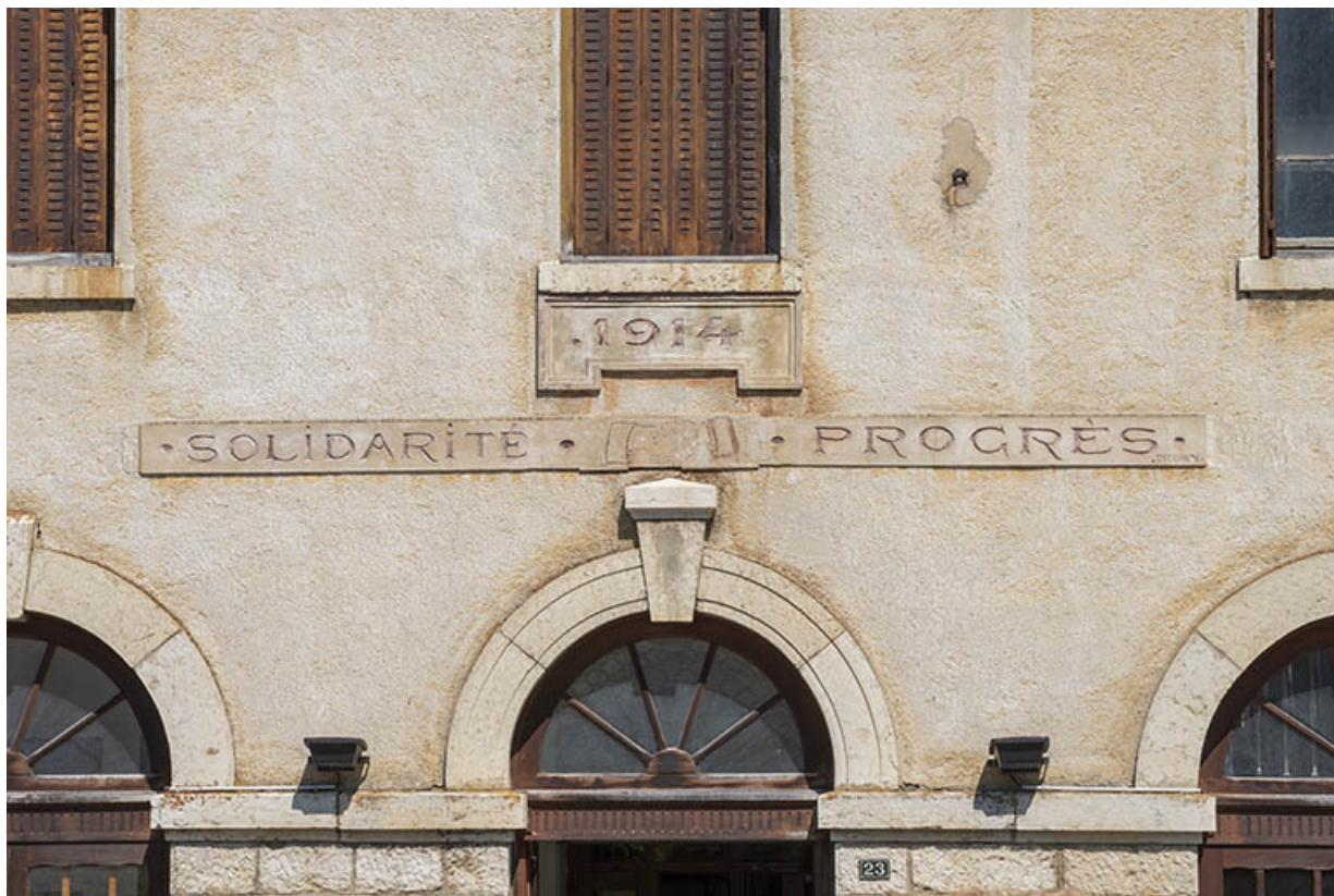
Détail du fronton de la façade.
