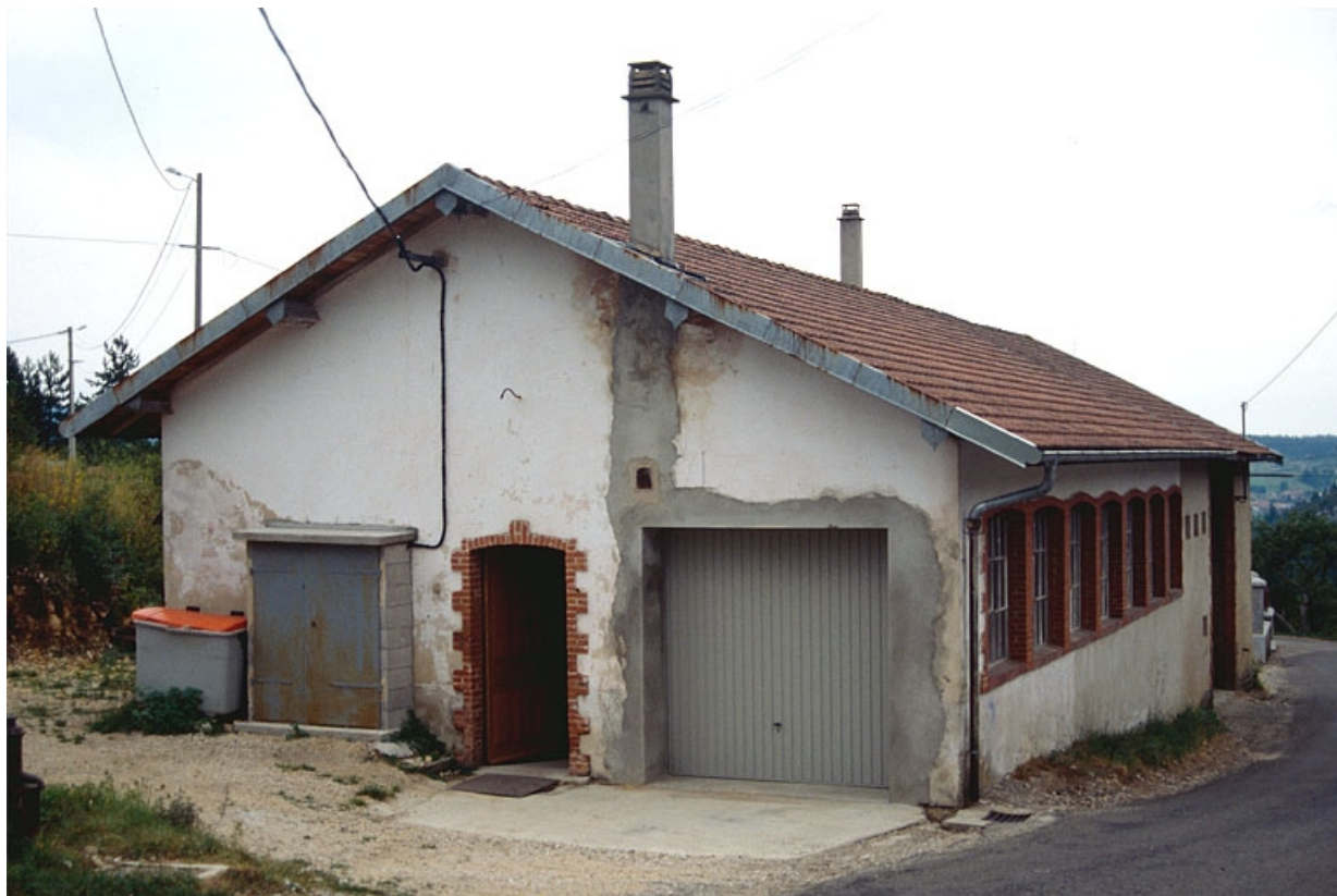
Façades antérieure et latérale droite.
