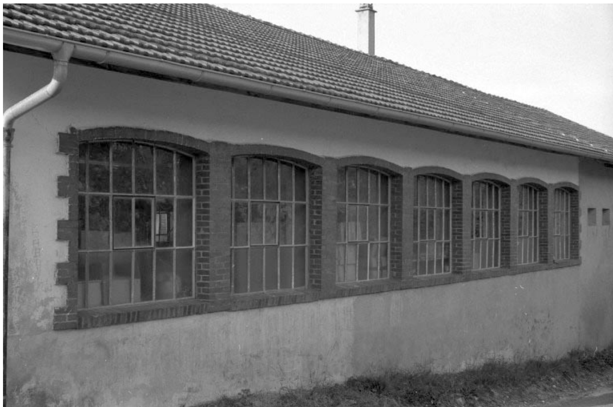
Fenêtres de la façade latérale droite.
