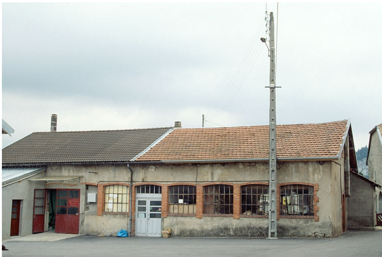
Façade antérieure du second bâtiment.
