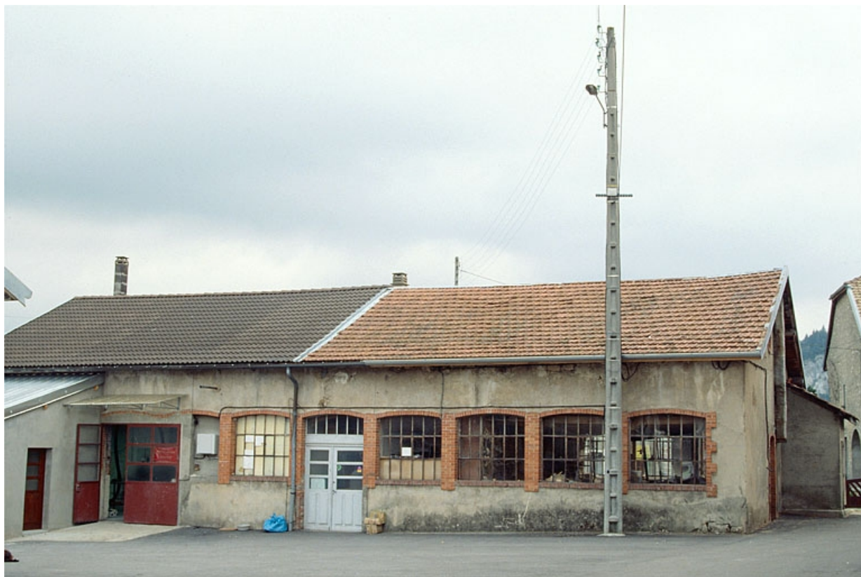
Façade antérieure du second bâtiment.
