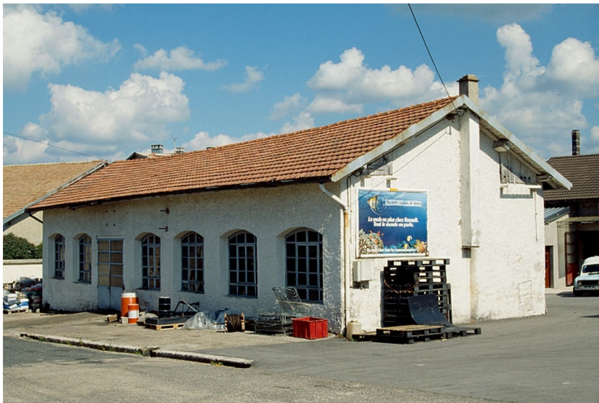
Premier bâtiment, vu de trois quarts droit.
