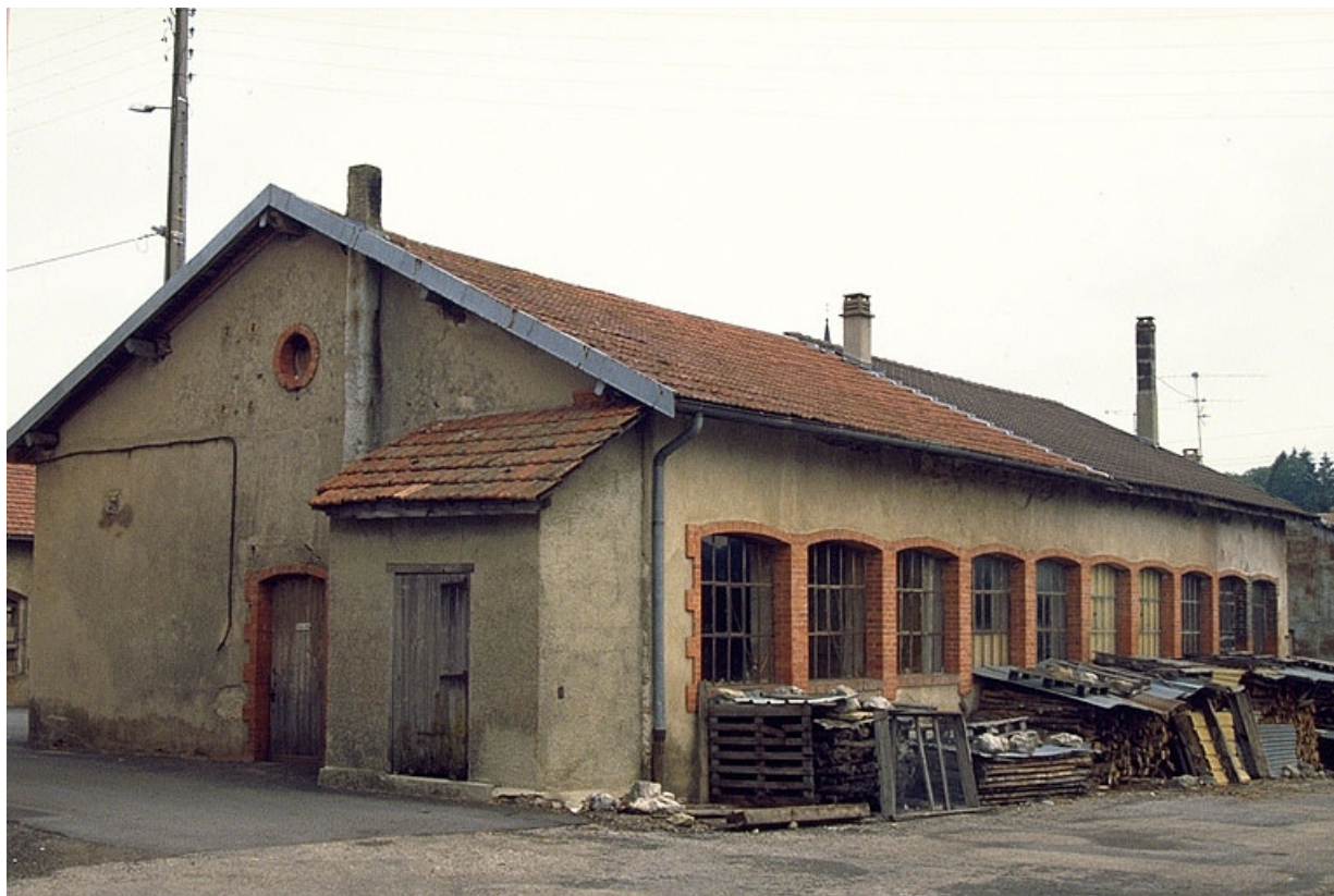
Façades postérieure et latérale droite du second bâtiment.
