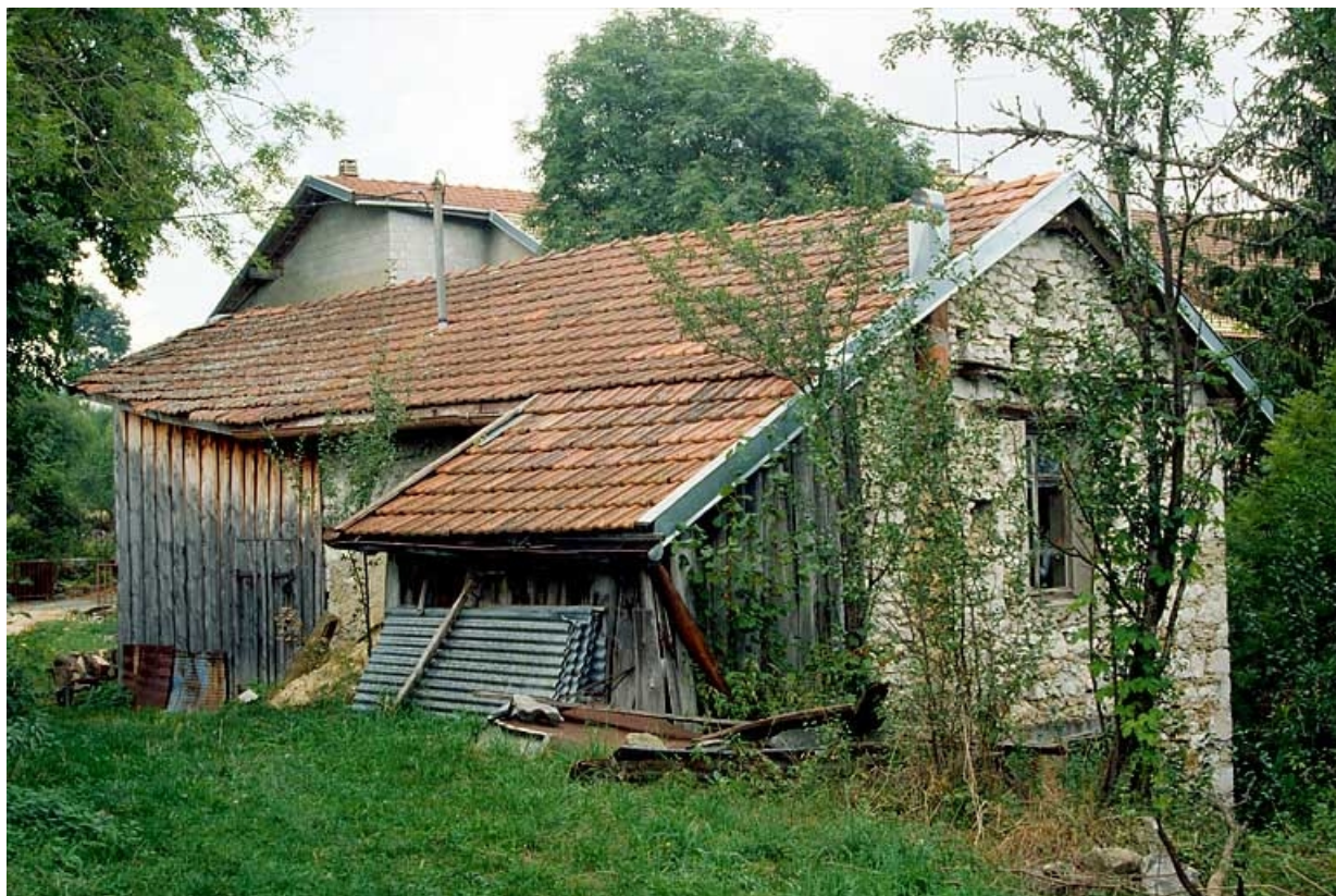
Façades postérieure et latérale droite. 39, Viry
