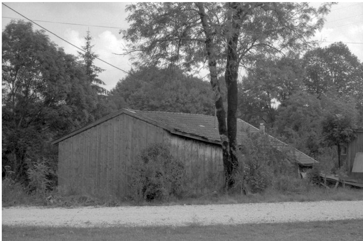
Façades antérieure et latérale droite.
