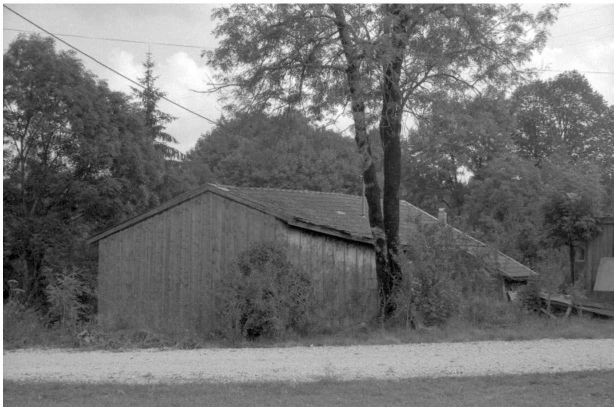
Façades antérieure et latérale droite.
