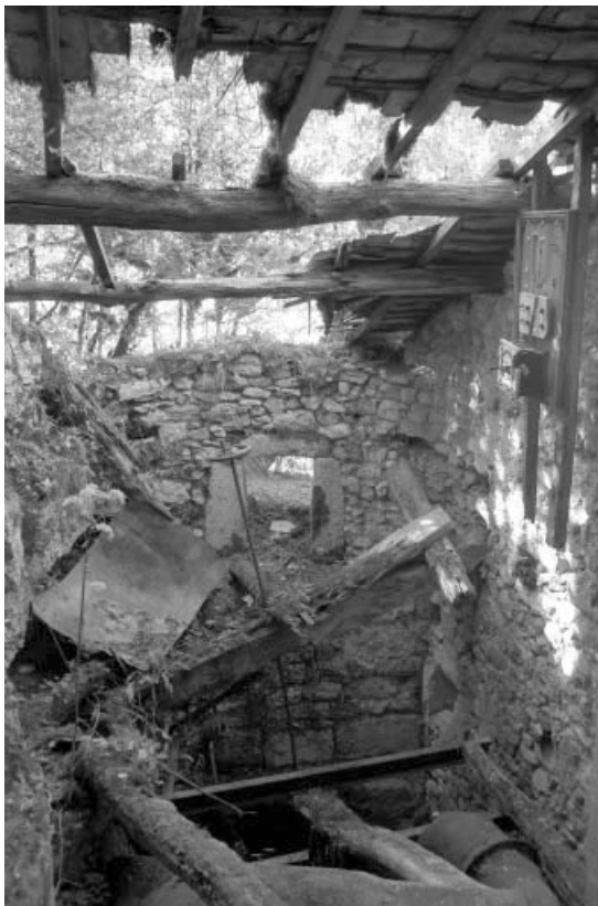
Site de la cascade : intérieur du bâtiment d'eau.
