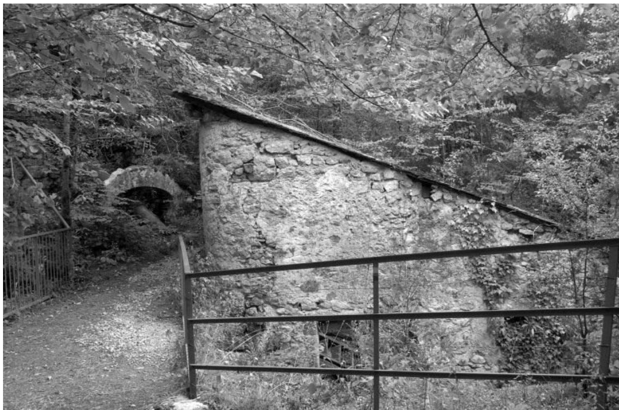
Site de la cascade : bâtiment d'eau.
