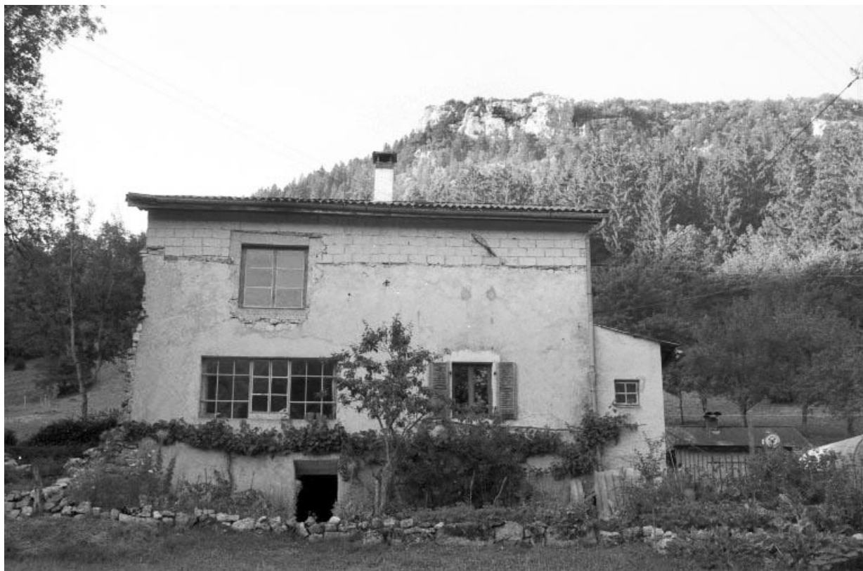
Façade latérale gauche. 39, Vulvoz, lieudit : au Closet
