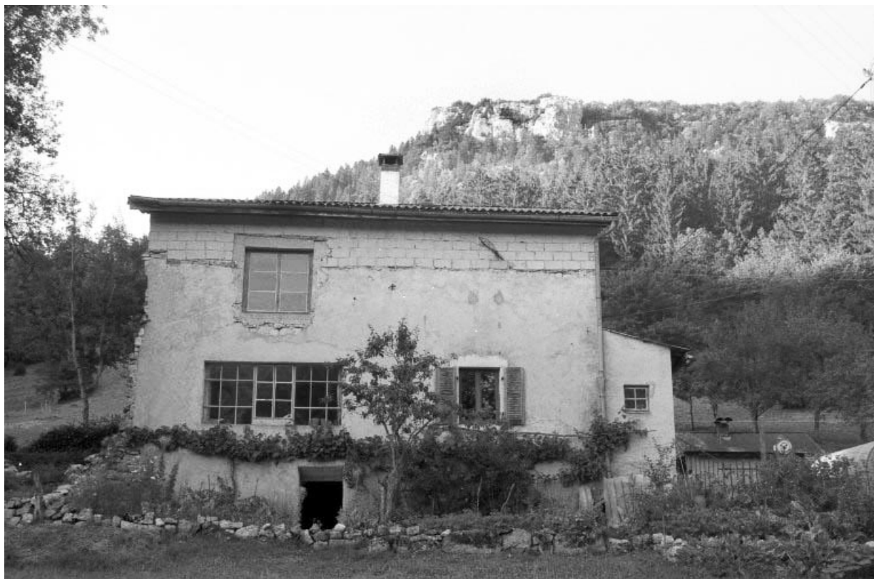
Façade latérale gauche. 39, Vulvoz, lieudit : au Closet
