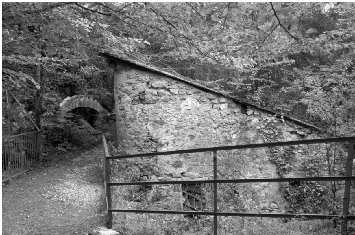
Site de la cascade : bâtiment d'eau.
