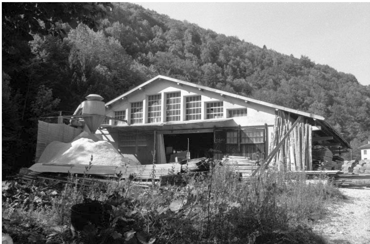
Façade postérieure de la scierie.
