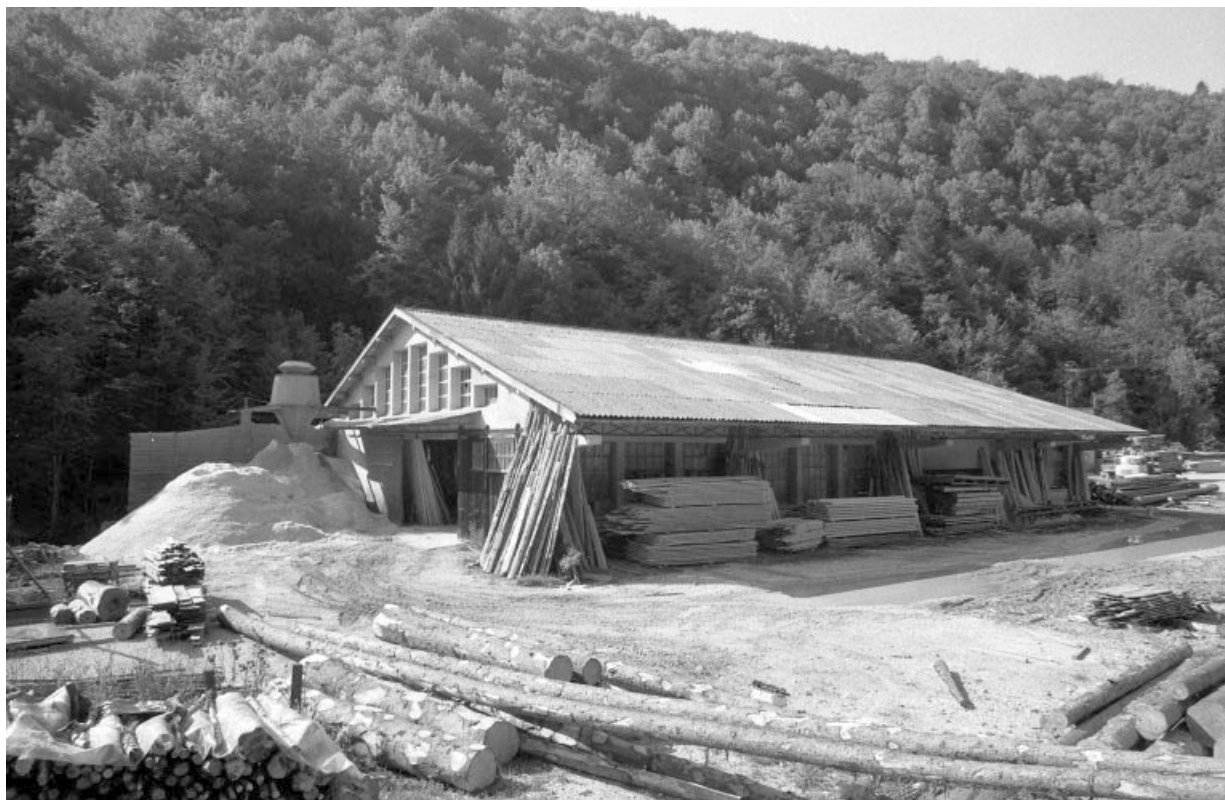
Façade latérale gauche de la scierie.
