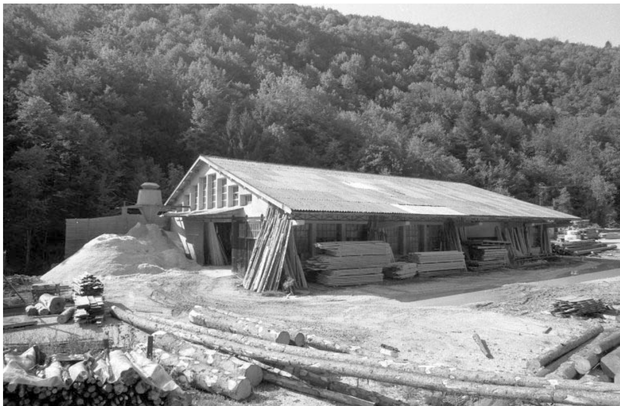
Façade latérale gauche de la scierie.
