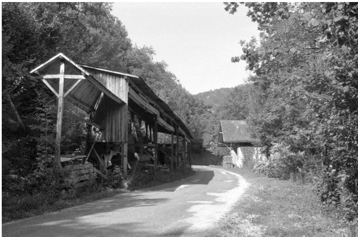
Séchoir à bois et magasin industriel.
