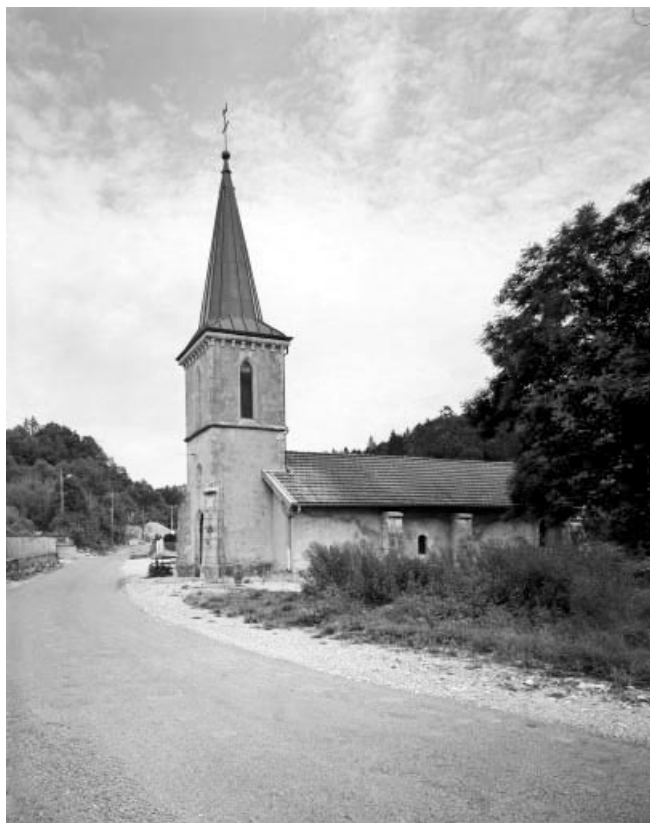
Extérieur : face sud et tour-clocher.
