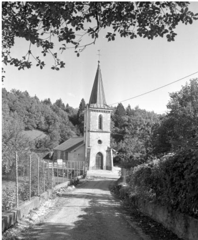
Extérieur : façade occidentale.
