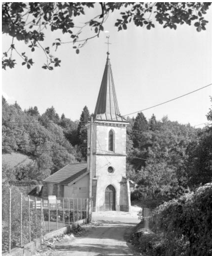
Extérieur : façade occidentale, vue de trois quarts.
