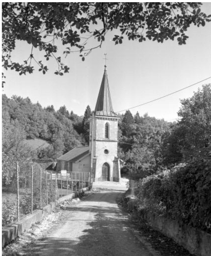
Extérieur : façade occidentale.
