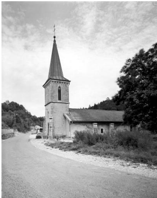
Extérieur : face sud et tour-clocher.
