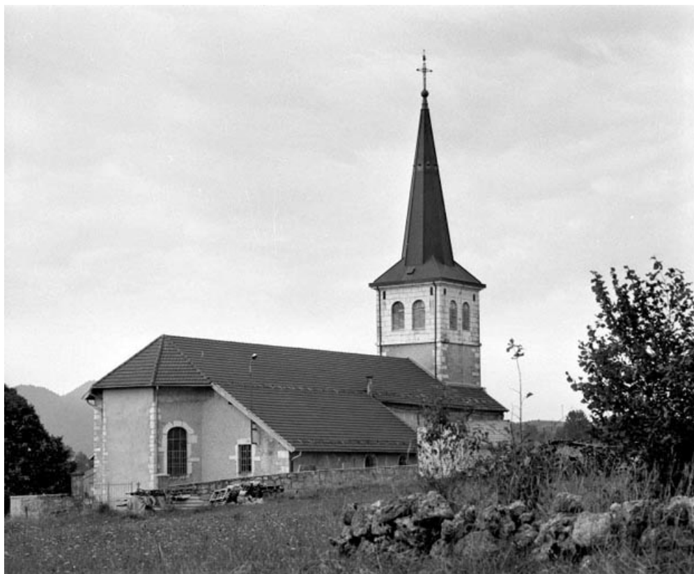
Extérieur : vue générale depuis le nord-est.
