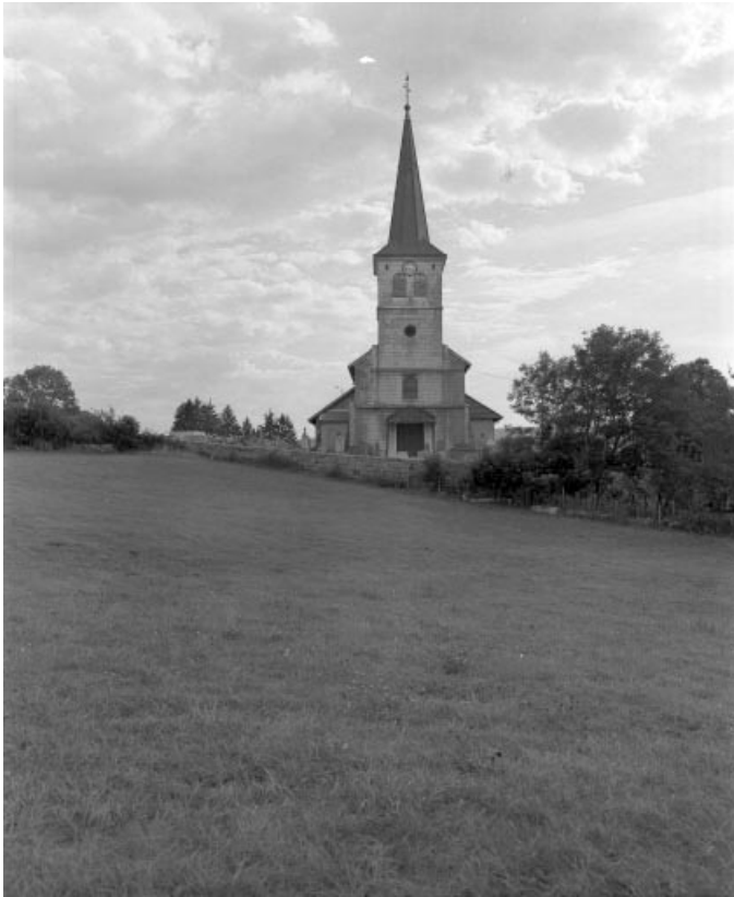
Vue de situation depuis l'ouest.
