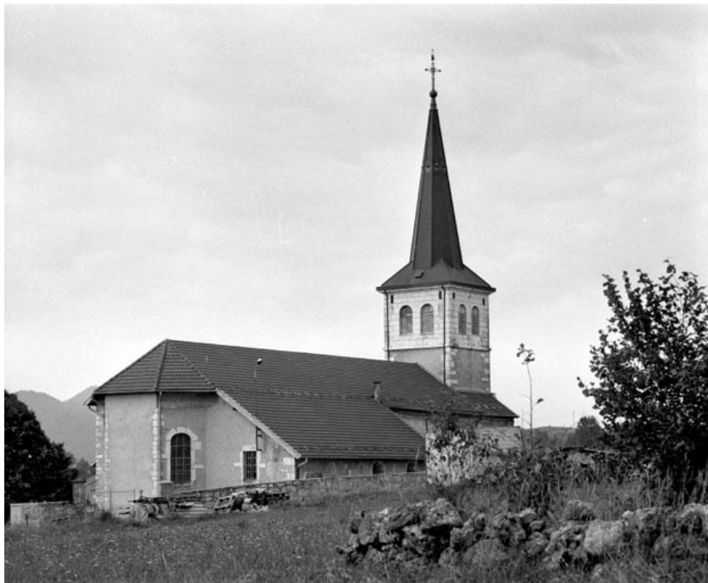
Extérieur : vue générale depuis le nord-est.
