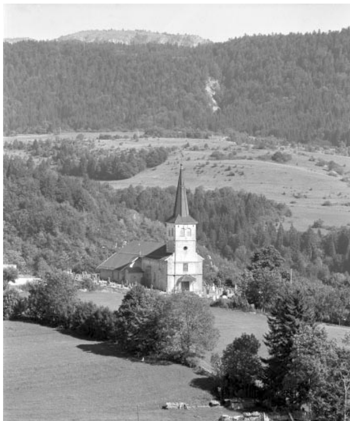
Vue de situation depuis le nord-ouest.
