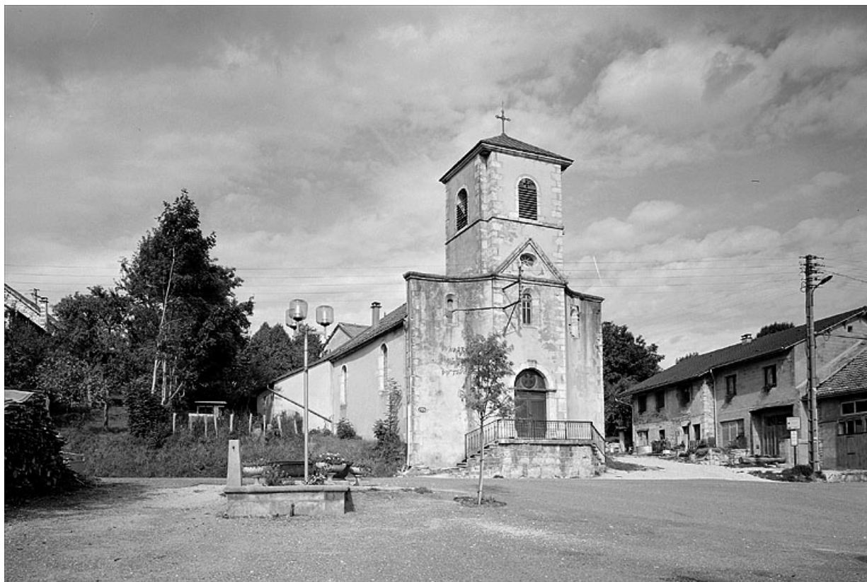
Extérieur : façade ouest et face sud.
