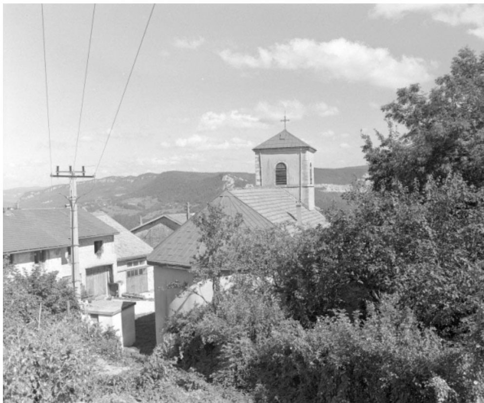
Extérieur : l'abside vue depuis le nord-est.
