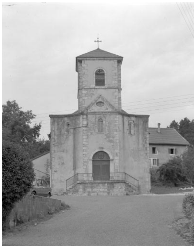
Extérieur : façade ouest.
