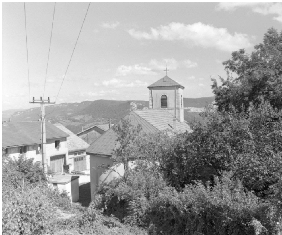
Extérieur : l'abside vue depuis le nord-est.
