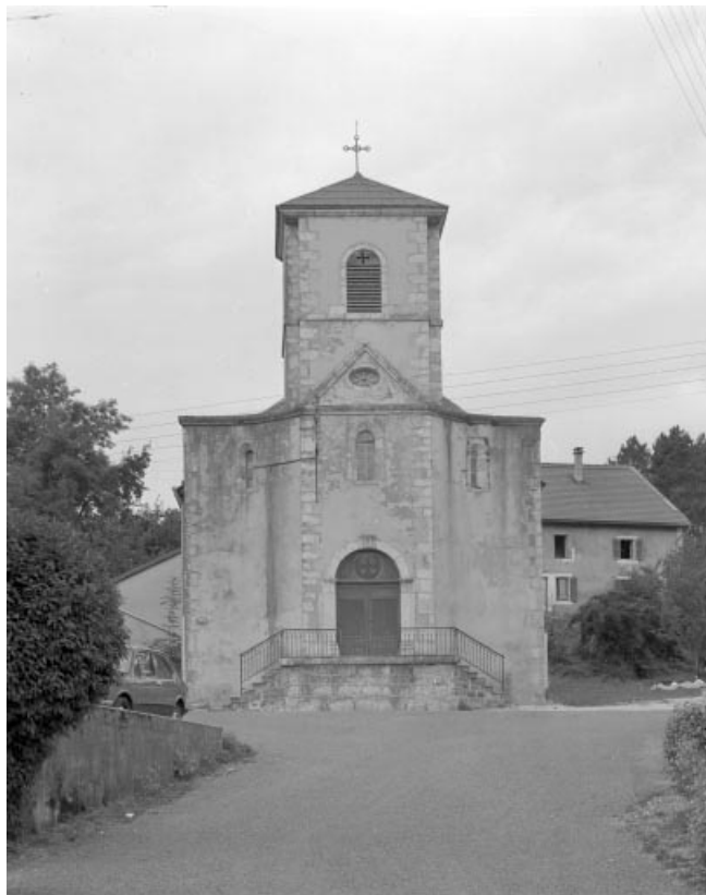
Extérieur : façade ouest.
