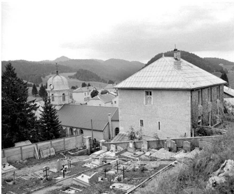
Extérieur : vue de situation depuis le sud-est.
