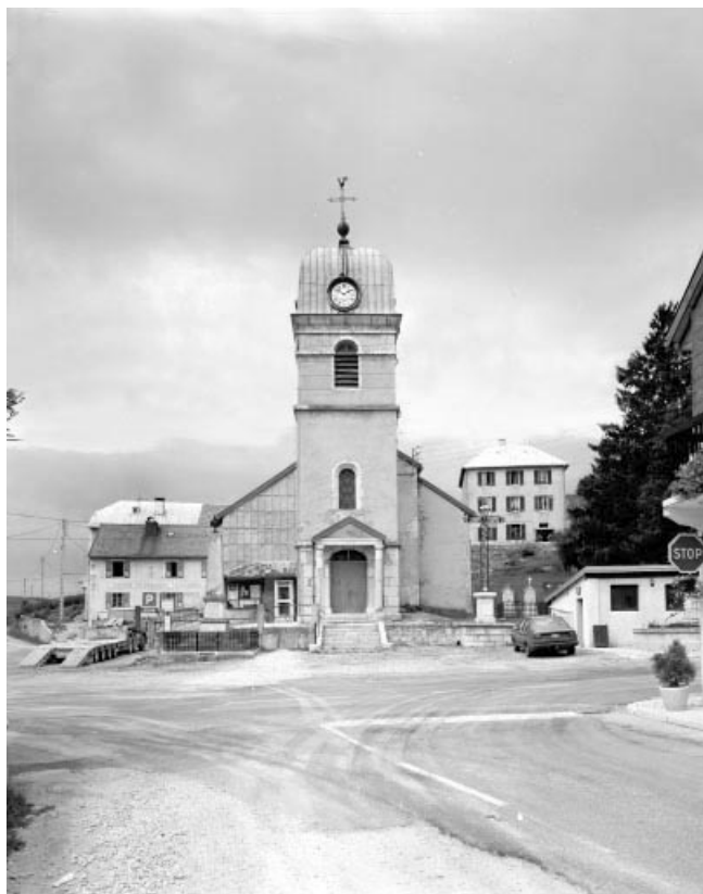
Extérieur : façade occidentale.
