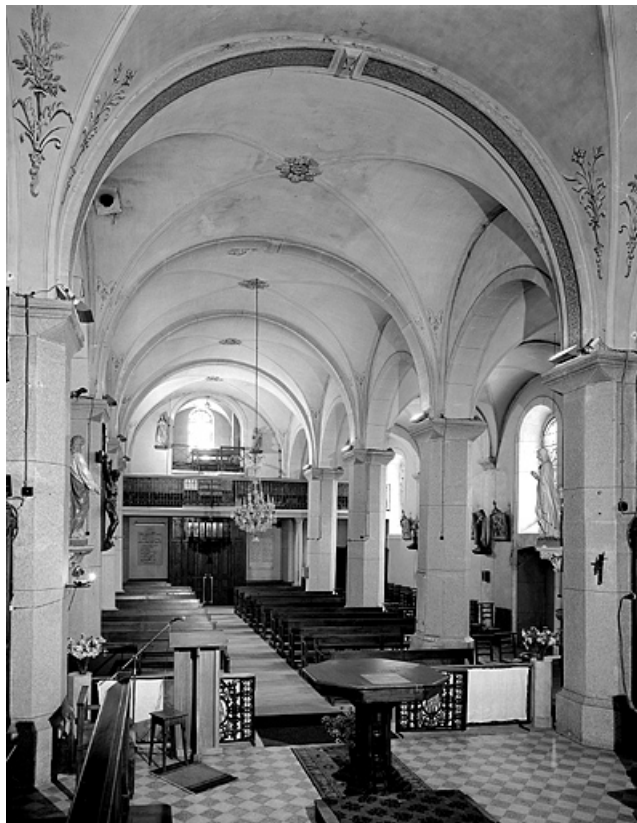
Élévation intérieure nord de la nef, vue depuis le chœur. 39, La Pesse
