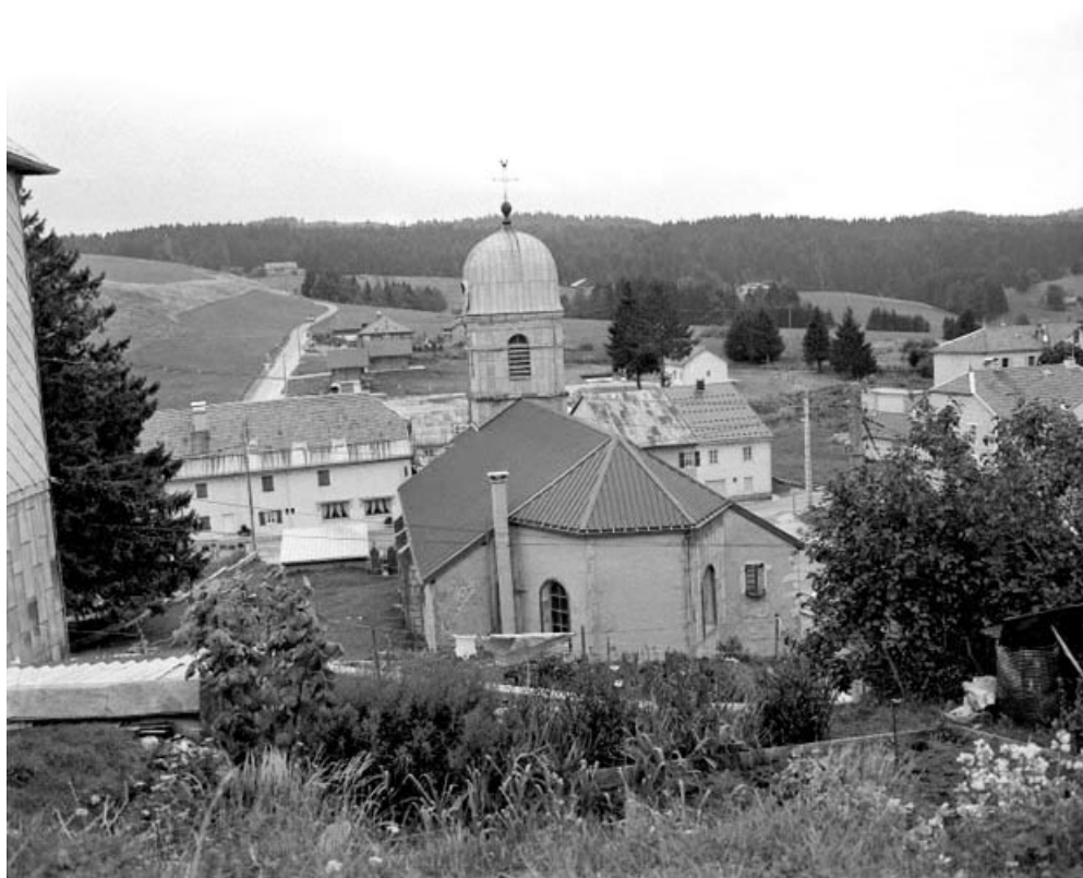
Extérieur : l'abside vue de face.
