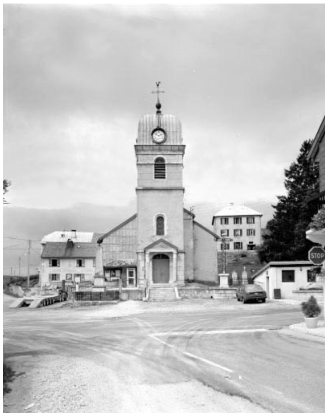
Extérieur : façade occidentale.
