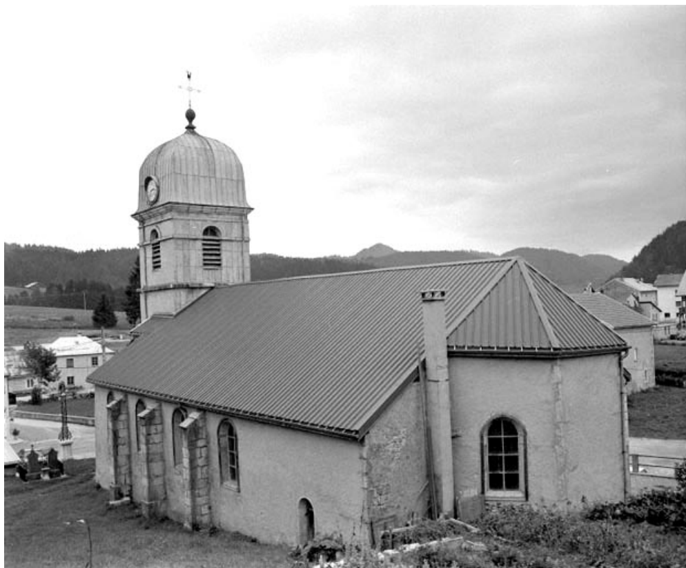
Extérieur : l'abside vue de trois quarts.
