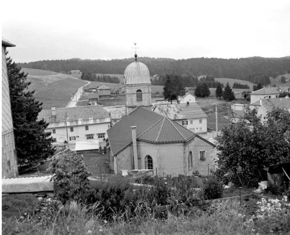
Extérieur : l'abside vue de face.
