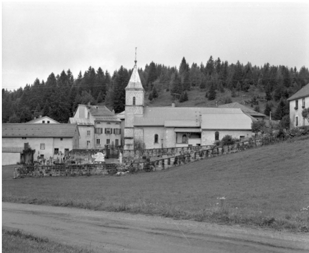
Extérieur : face sud.
