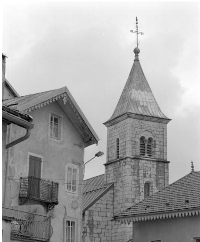
La tour-clocher vue depuis le nord-ouest.
