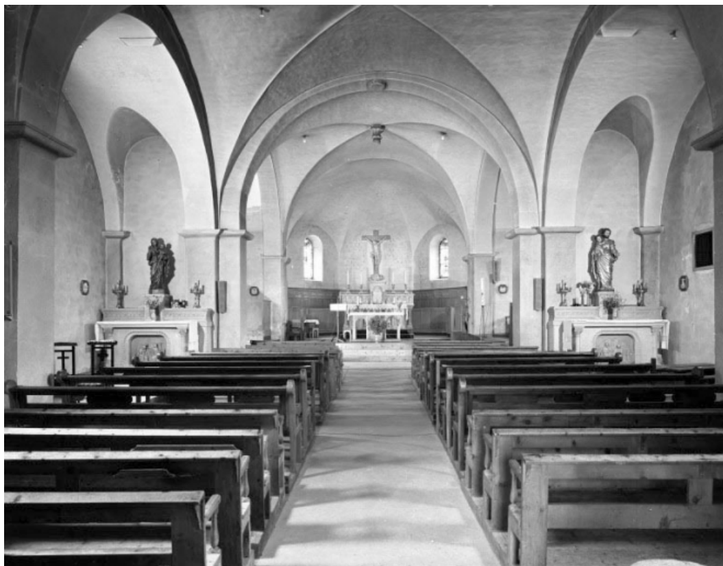
Le chœur vu depuis la nef.
