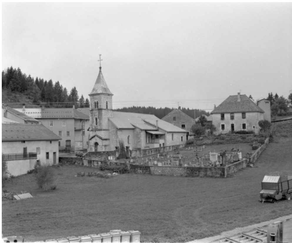
Vue de situation depuis le sud-ouest.
