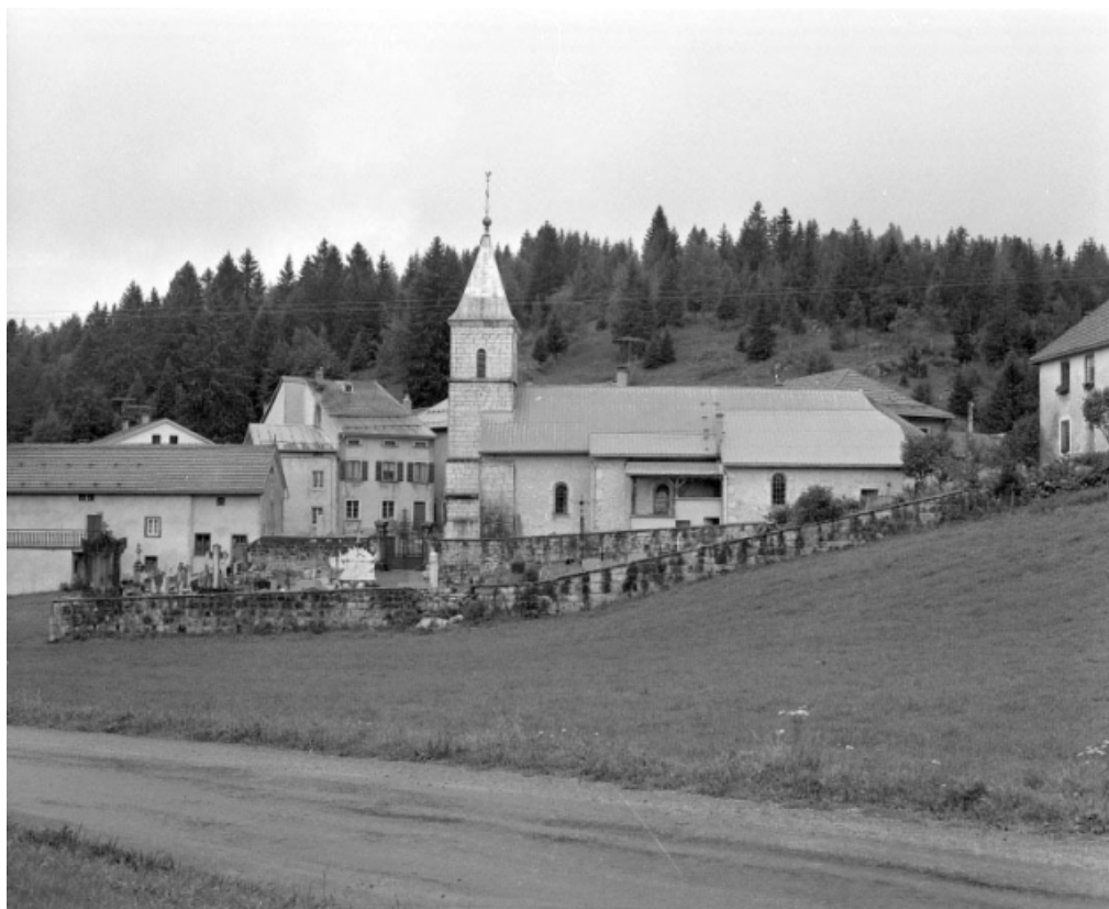
Extérieur : face sud.
