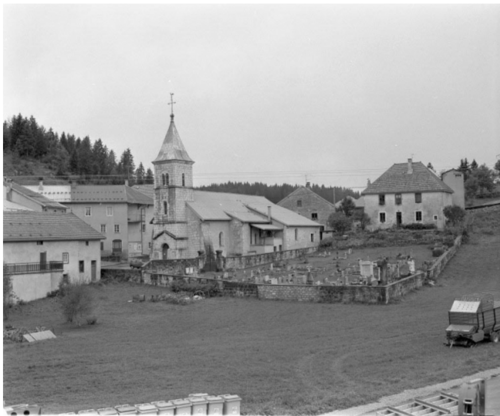
Vue de situation depuis le sud-ouest.
