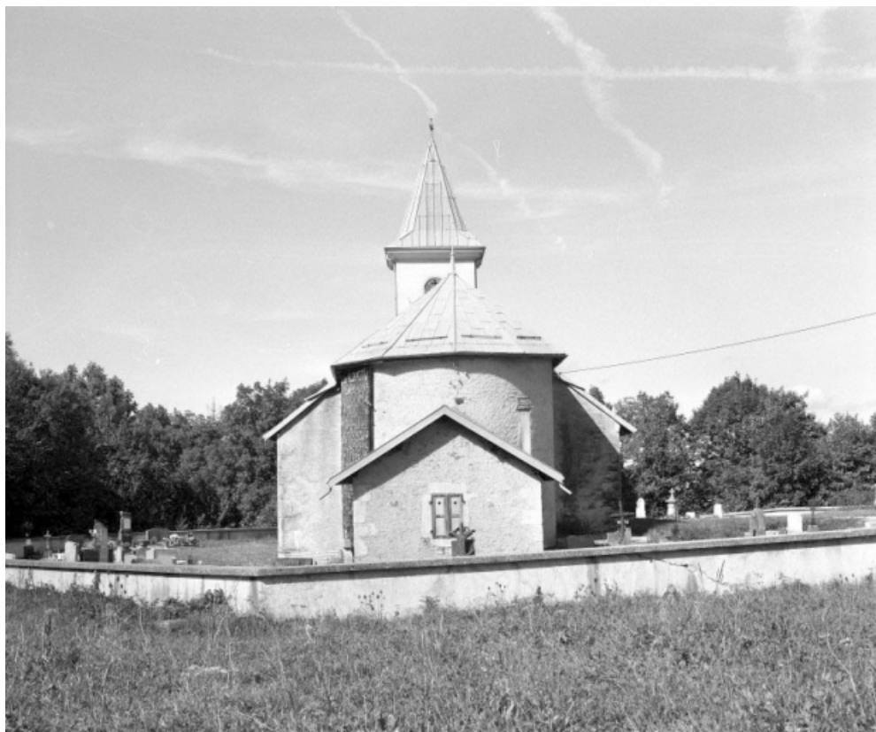
Extérieur : l'abside vue de face.
