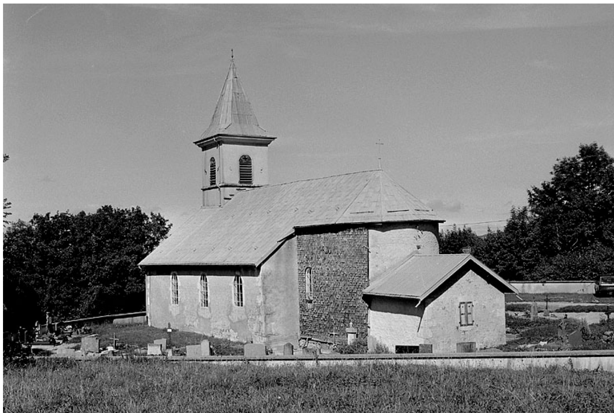
Extérieur : abside et face sud.
