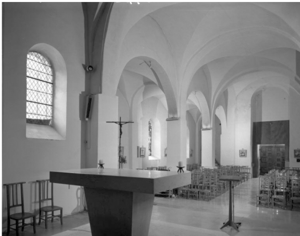
Intérieur : élévation sud du vaisseau central et bas-côté sud vus depuis le chœur (vue horizontale). 39, Larrivoire
