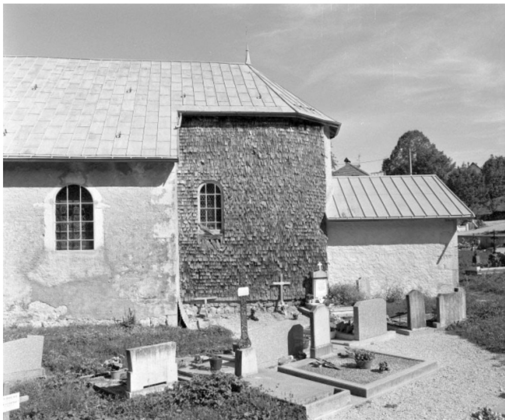
Extérieur : face sud de la dernière travée de la nef, du chœur et de la sacristie. 39, Larrivoire
