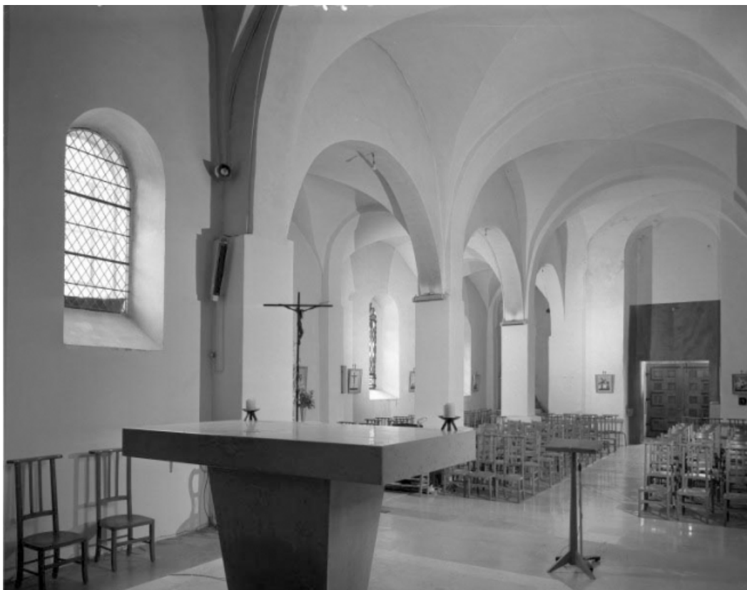
Intérieur : élévation sud du vaisseau central et bas-côté sud vus depuis le chœur (vue horizontale). 39, Larrivoire
