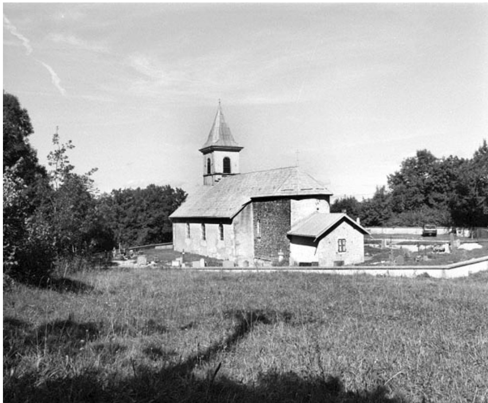
Extérieur : vue générale depuis le sud-ouest.
