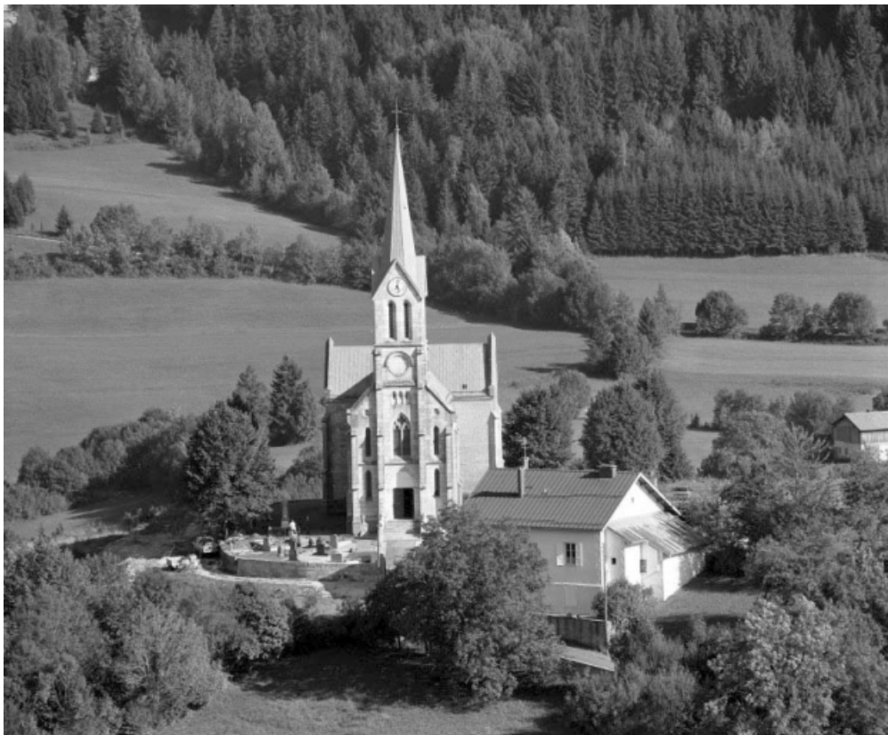
Extérieur : vue générale de la façade ouest.
