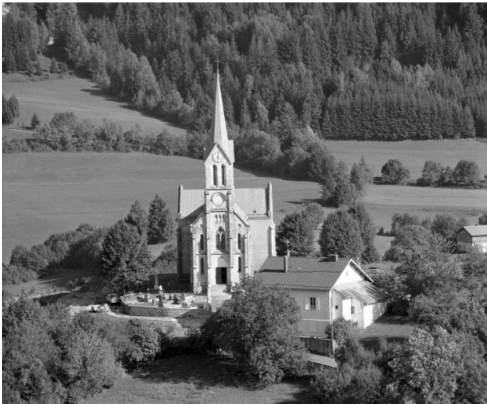
Extérieur : vue générale de la façade ouest.
