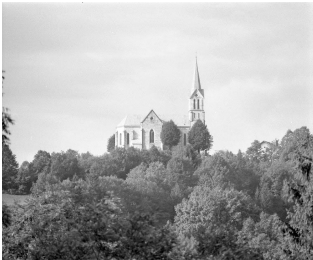
Extérieur : vue générale de la face nord.
