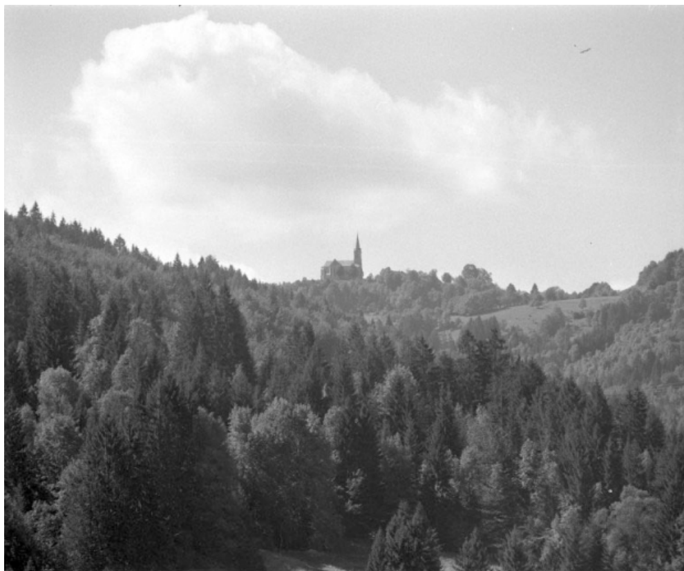
Extérieur : vue depuis le village de Vulvoz.
