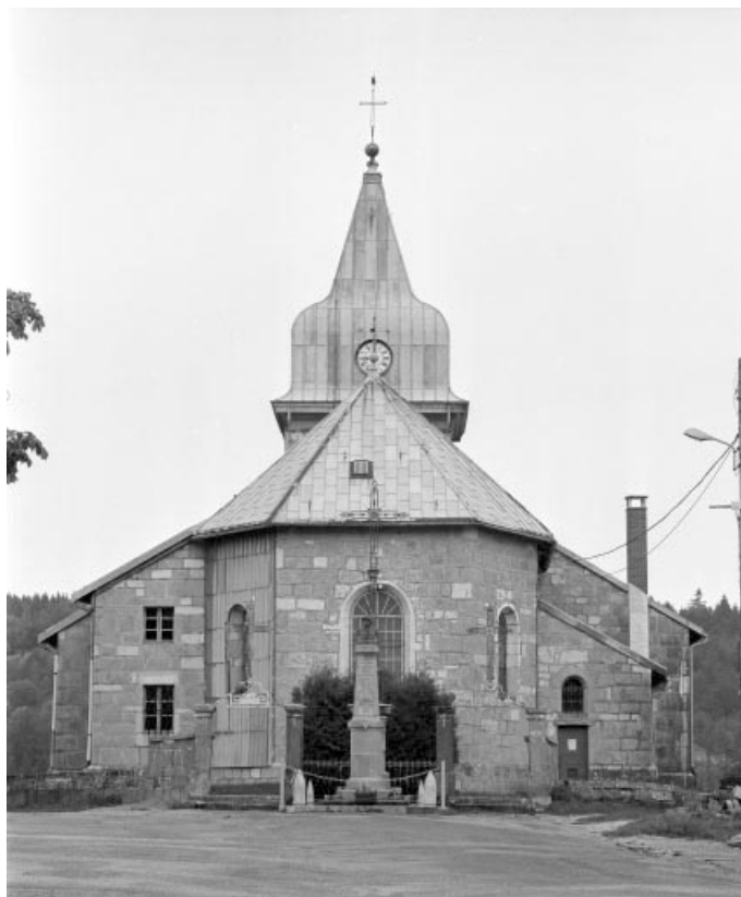
Extérieur : l'abside, vue de face.
