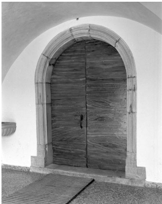
Le portail d'entrée de la nef.
