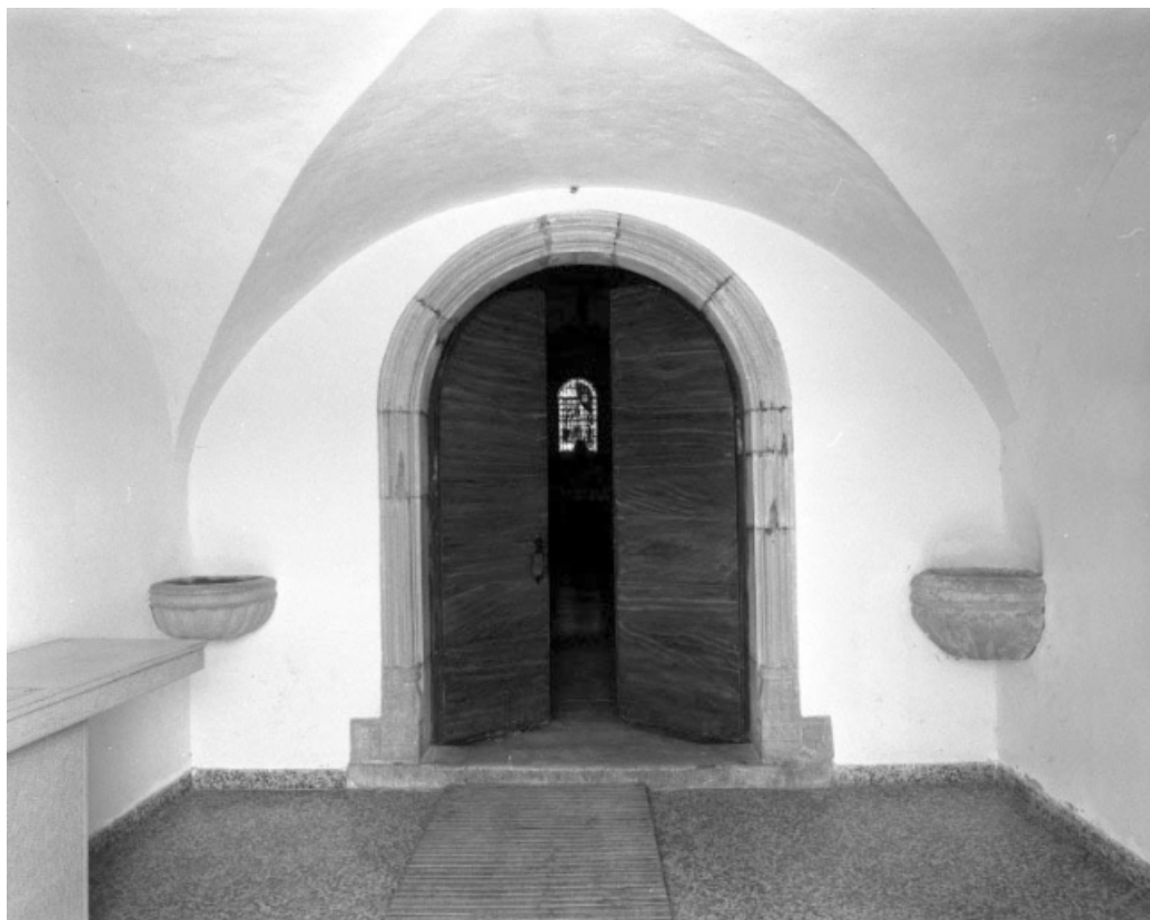
Le vestibule sous la tour-clocher.
