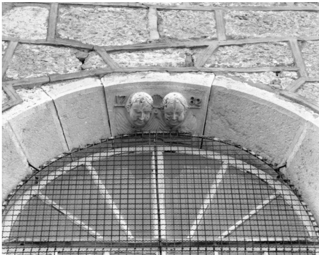
Extérieur : partie supérieure de la baie de l'abside, têtes d'angelots et date 1782. 39, Les Bouchoux
