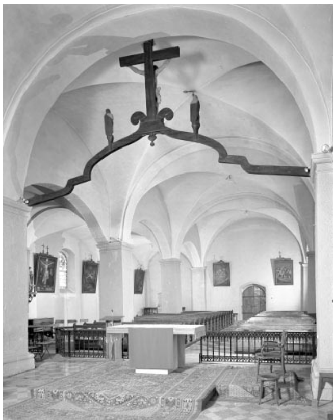
Élévation intérieure sud de la nef, vue depuis le chœur.
