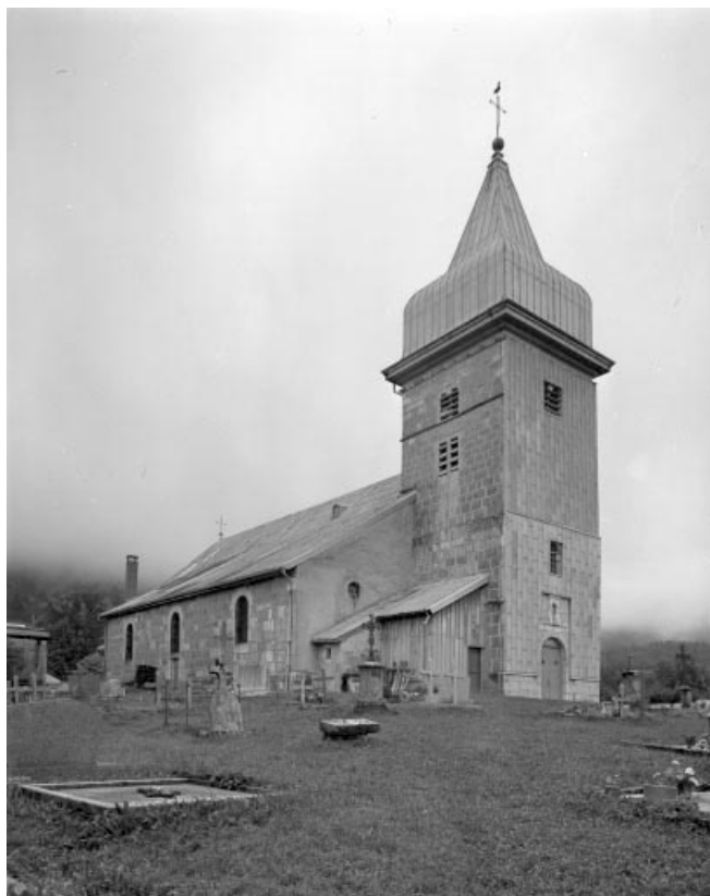
Extérieur : façade occidentale et face nord.
