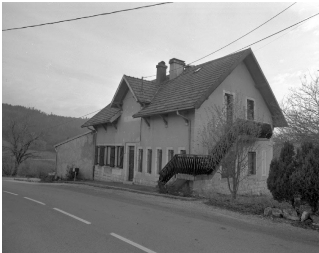
Façade antérieure et face droite.
