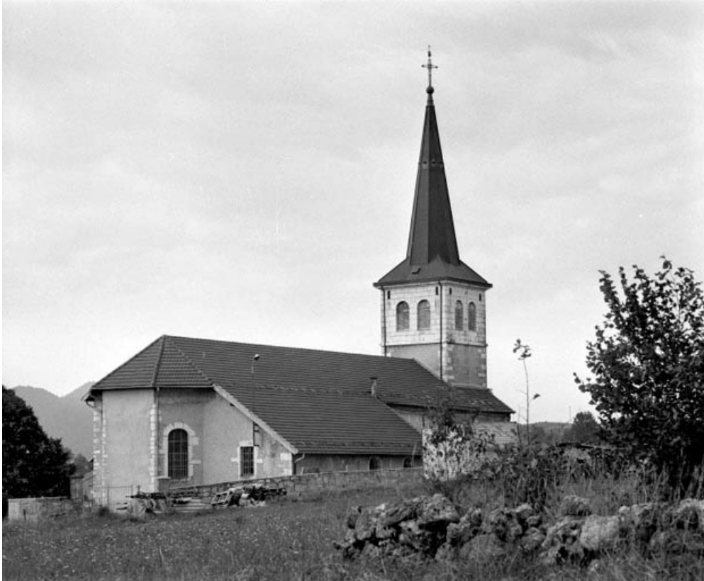
Extérieur : vue générale depuis le nord-est.
