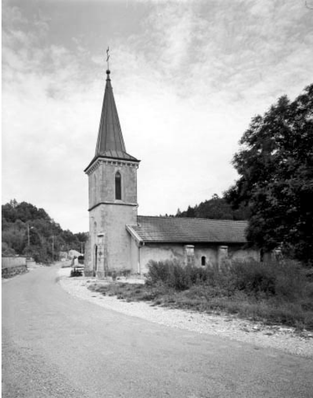
Extérieur : face sud et tour-clocher.
