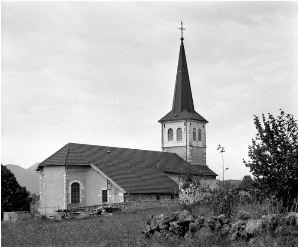
Extérieur : vue générale depuis le nord-est.
