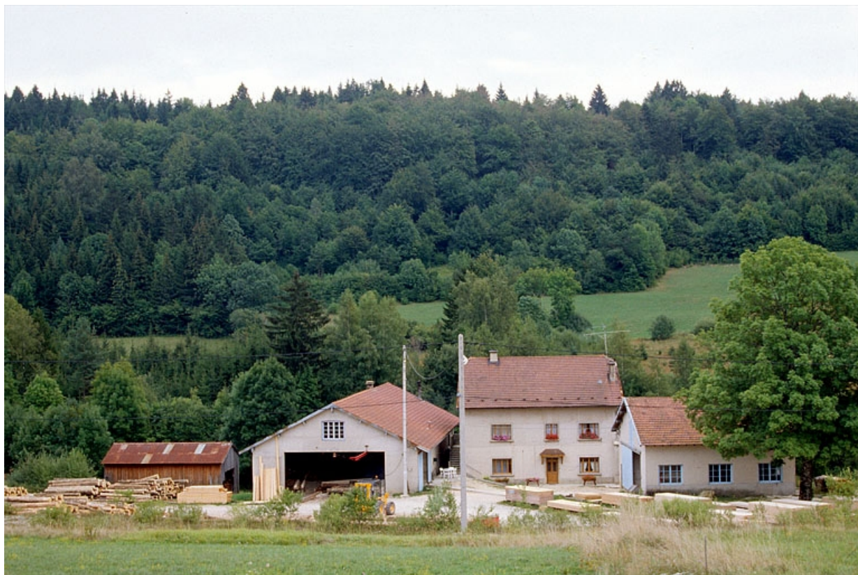
Vue d'ensemble, depuis l'ouest.
