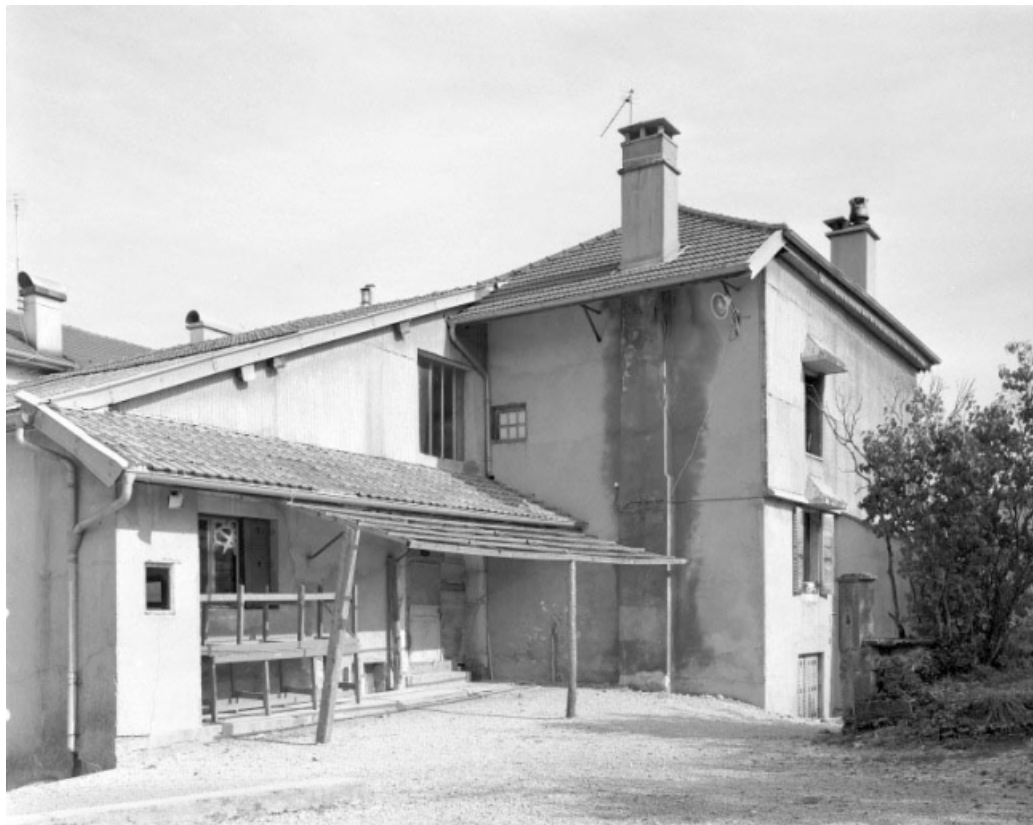
Côté droit du bâtiment.
