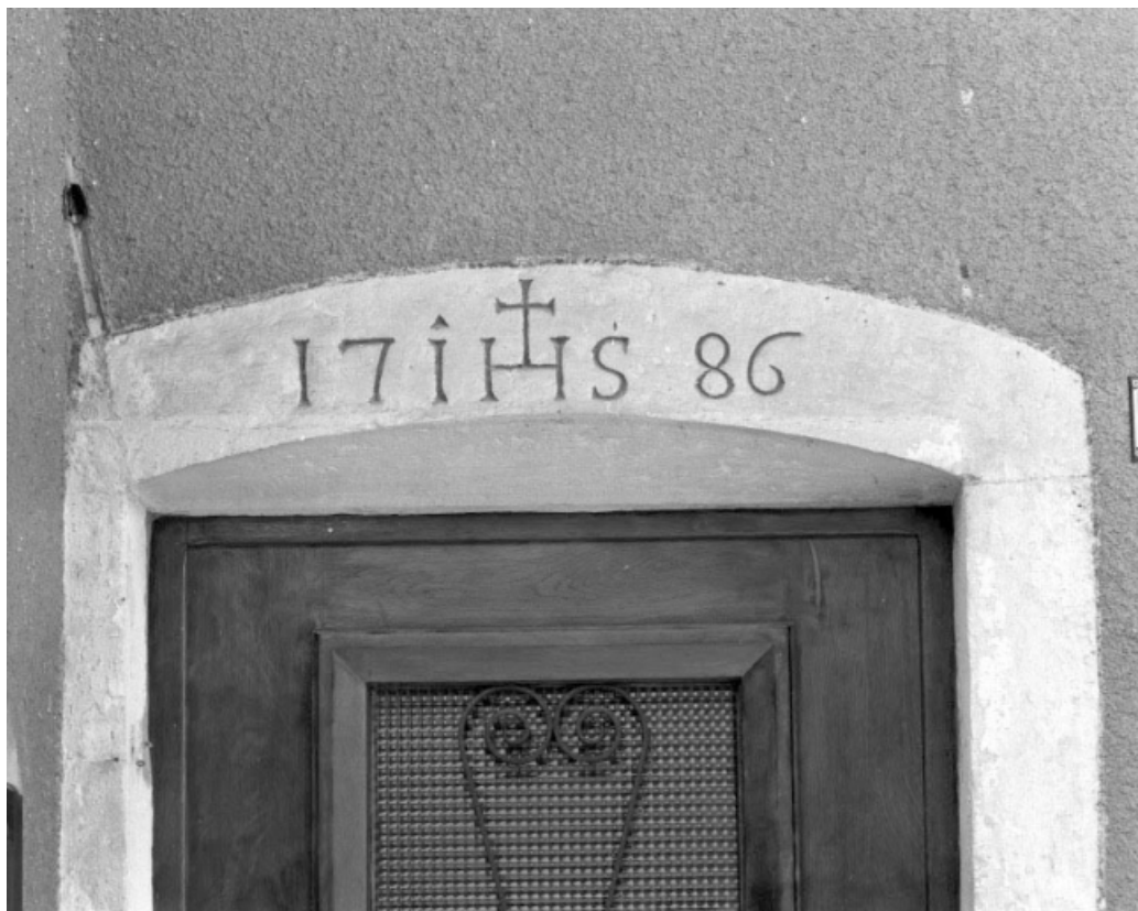
Linteau de la porte du rez-de-chaussée.
