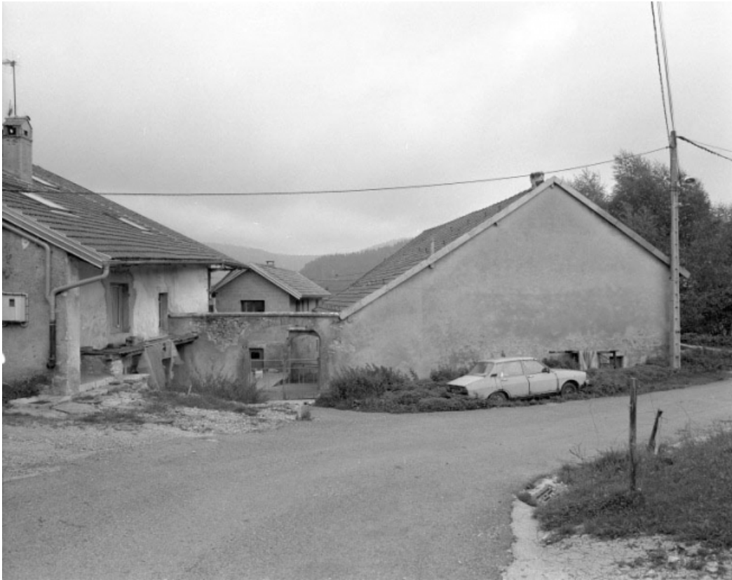
Vue générale de l'accès à la maison.
