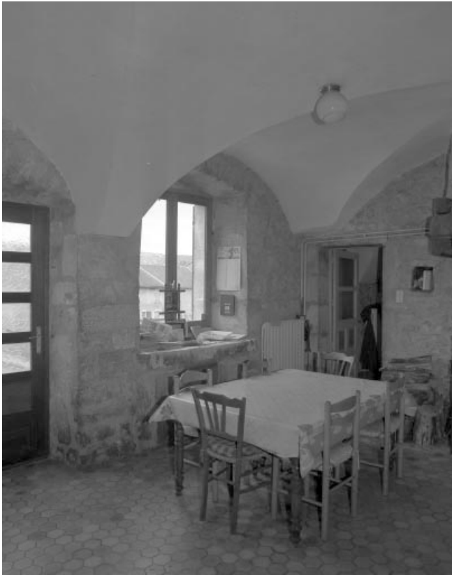
Intérieur du rez-de-chaussée : voûte d'arêtes. 39, Viry
