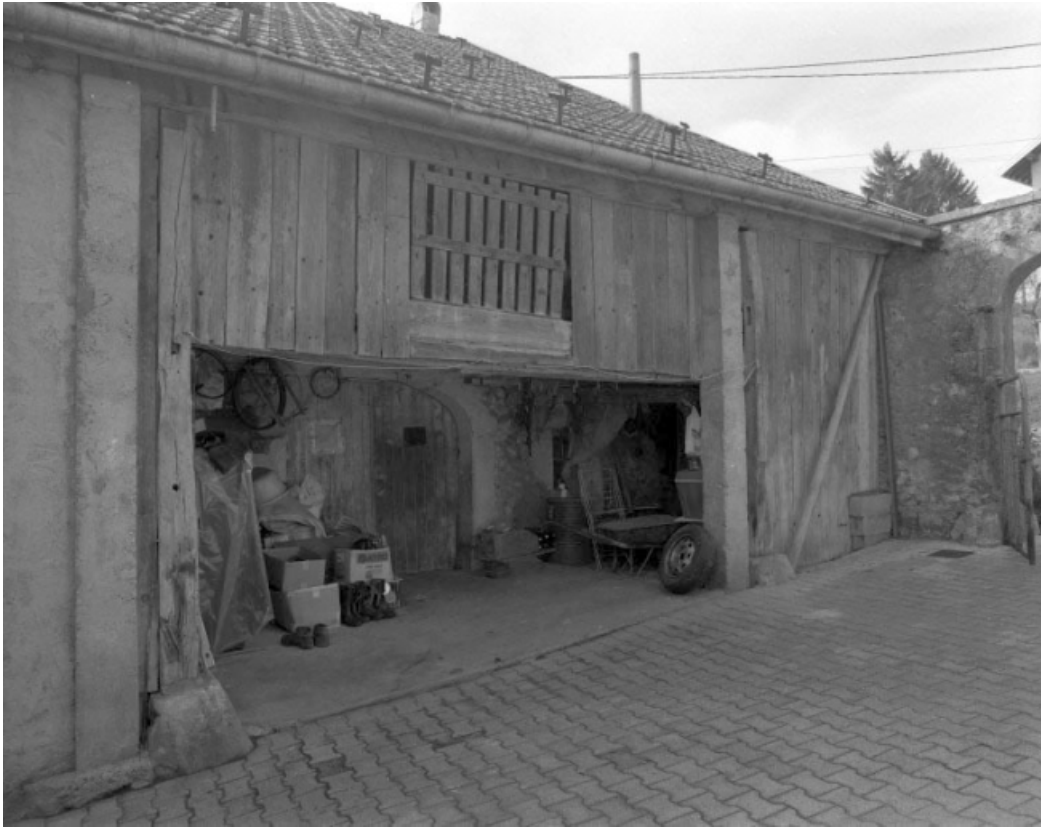
Accès à l'étable depuis la cour.
