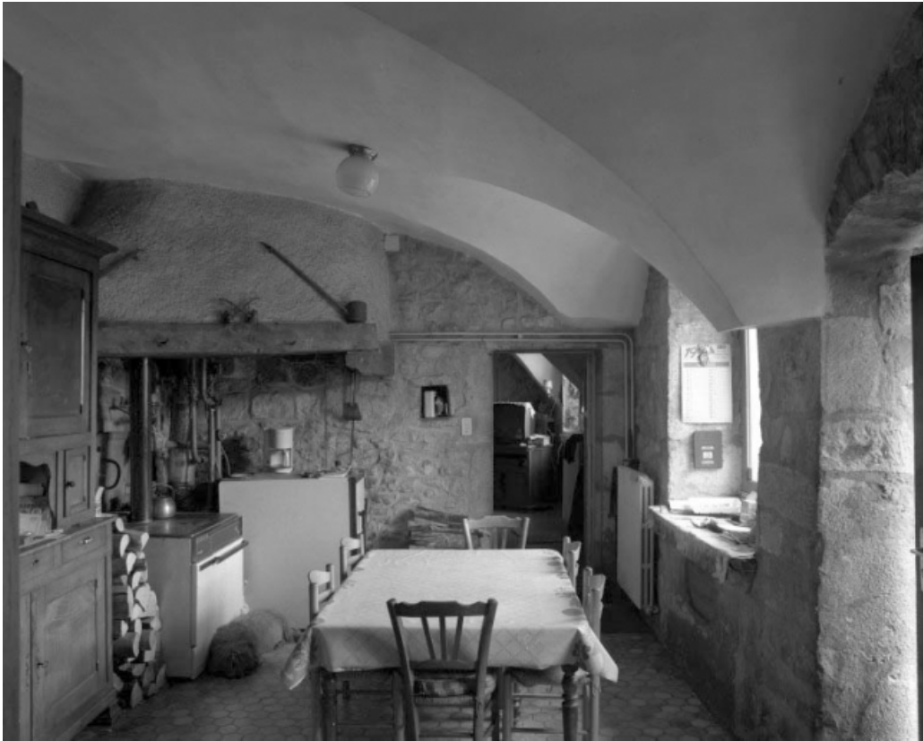
Intérieur de la cuisine : au fond à gauche, l'ancienne cheminée et la bouche du four. 39, Viry
