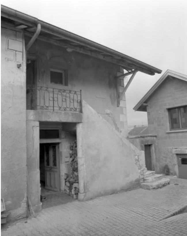
Partie droite de la façade antérieure.
