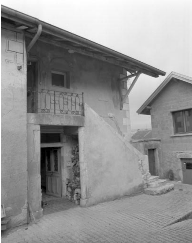
Partie droite de la façade antérieure.
