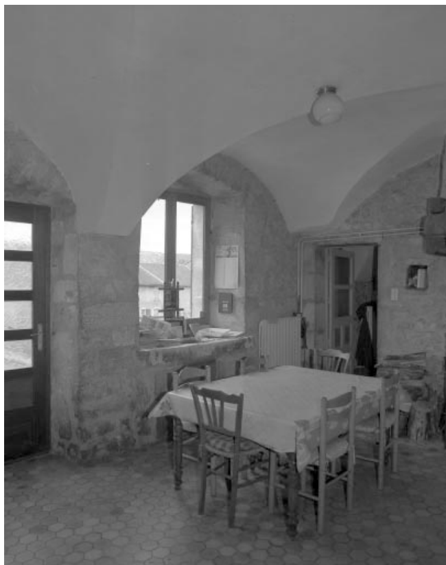
Intérieur du rez-de-chaussée : voûte d'arêtes.
