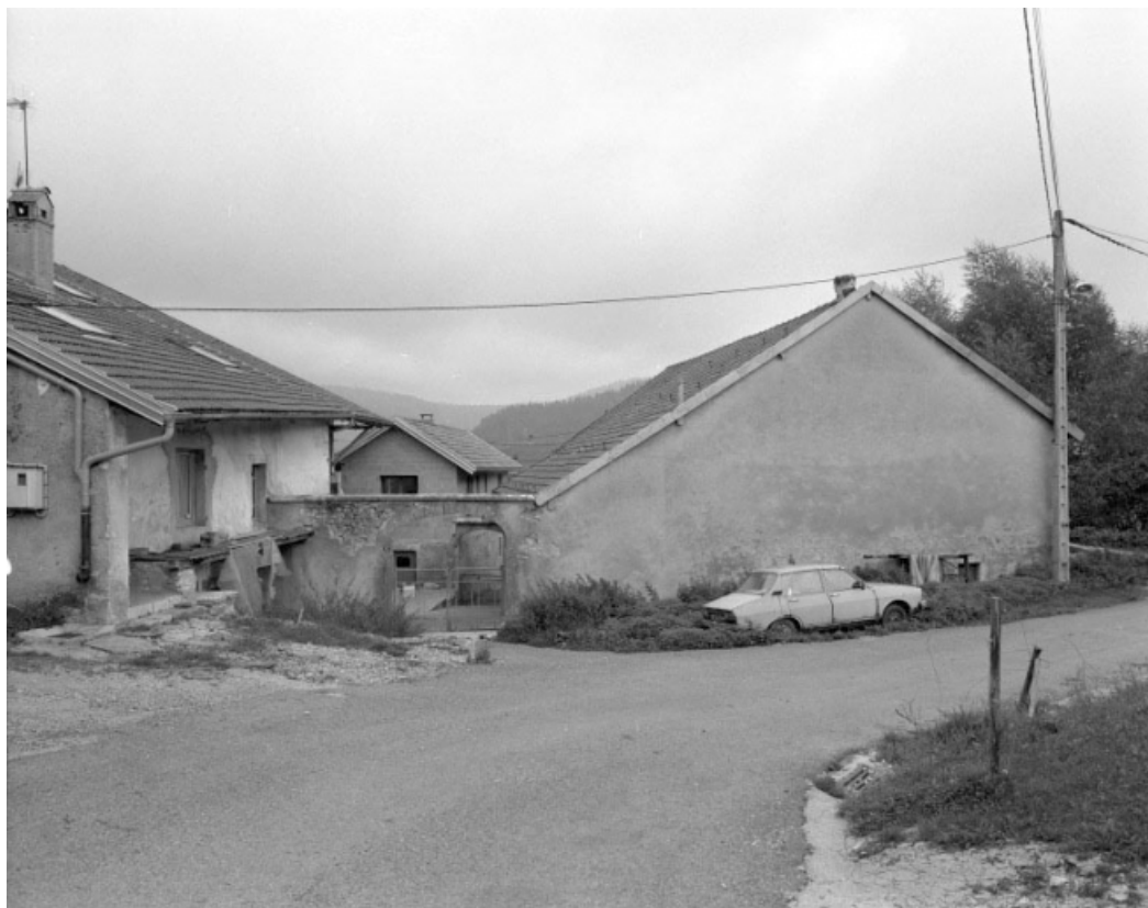
Vue générale de l'accès à la maison.
