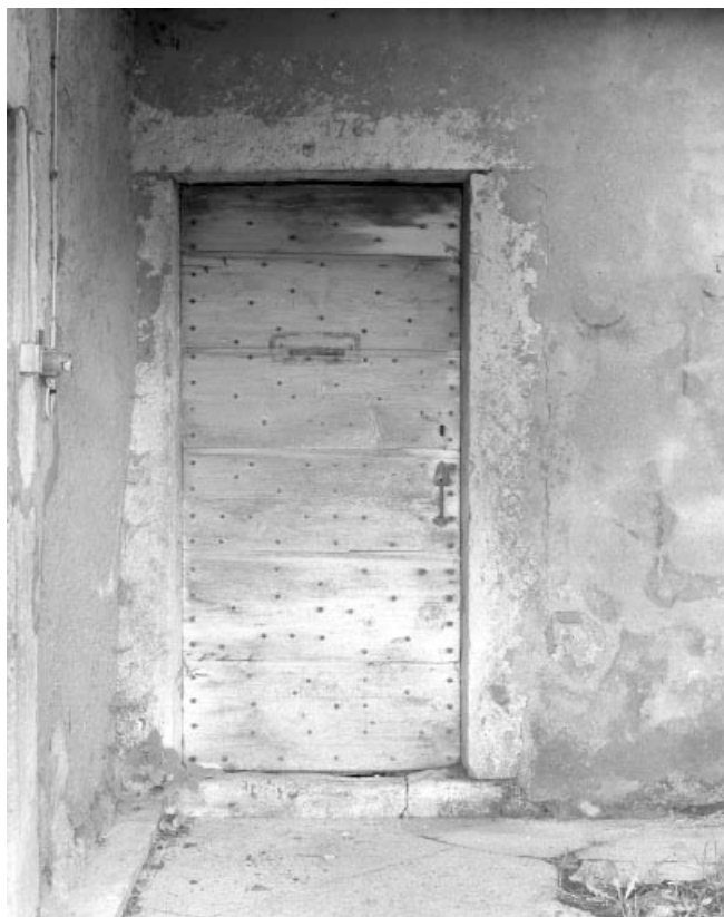
Porte d'accès au logis du rez-de-chaussée.
