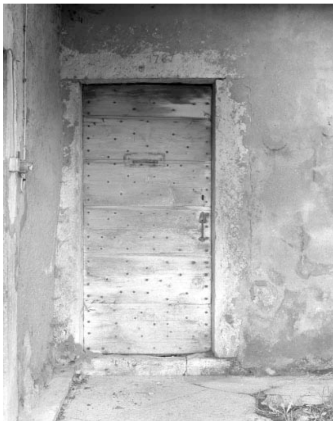
Porte d'accès au logis du rez-de-chaussée.
