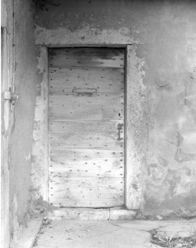
Porte d'accès au logis du rez-de-chaussée.
