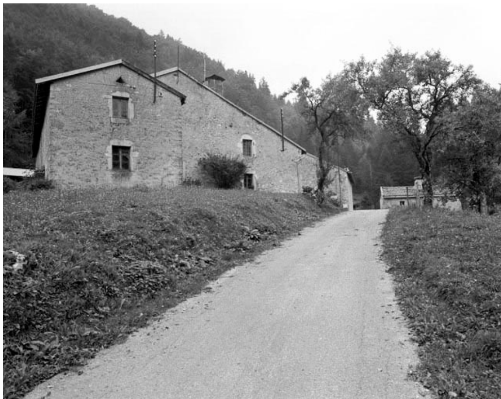
Vue générale, avec le fournil sur la droite.
