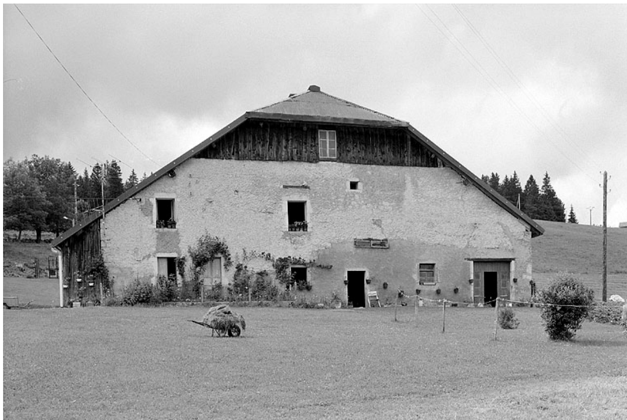
Face latérale de la ferme de la Muras.
