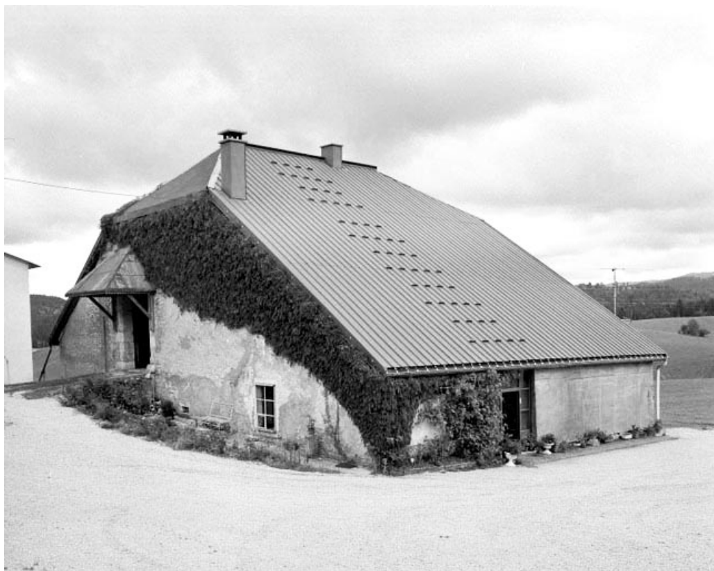
Façade postérieure et face latérale de la ferme de la Muras.
