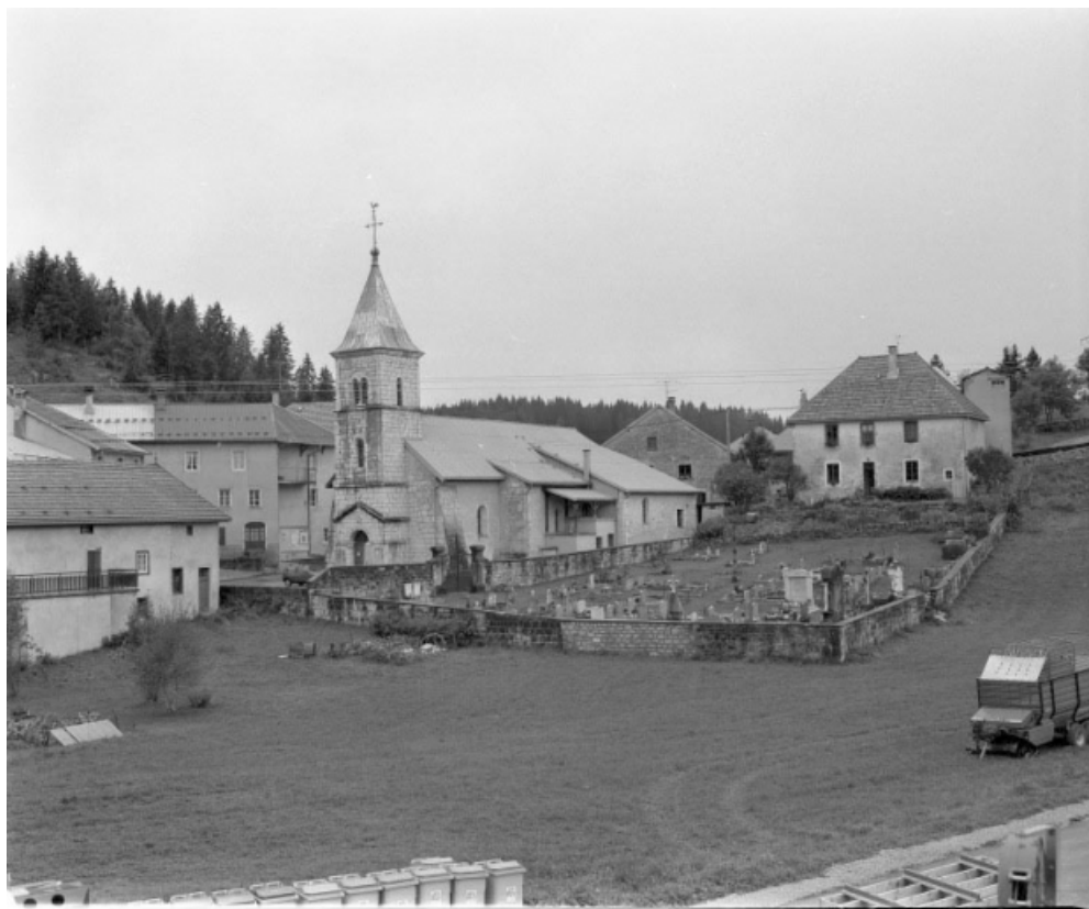
Vue de situation depuis le sud-ouest.
