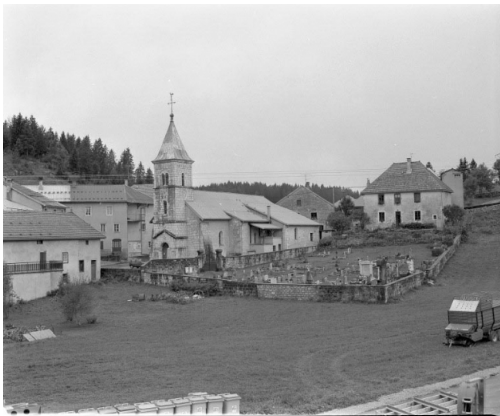
Vue de situation depuis le sud-ouest.
