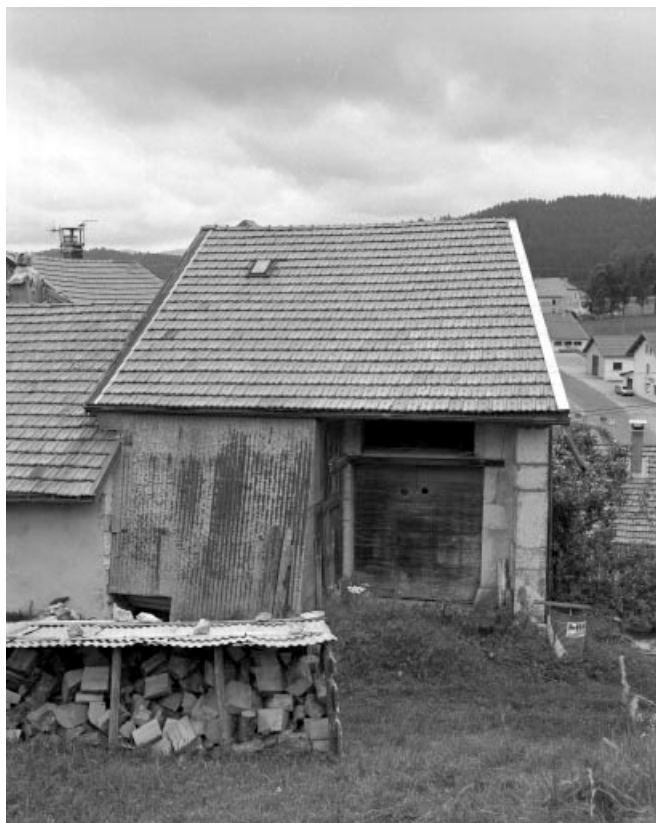
La rue Derrière, accès à une grange. 39, Les Moussières
