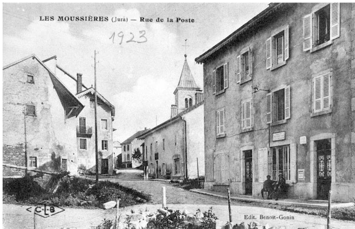
La rue de la Poste. 39, Les Moussières
