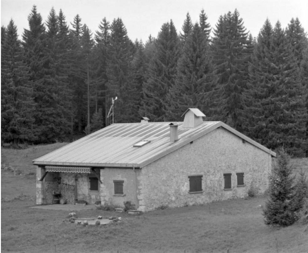
Façade antérieure et face droite.
