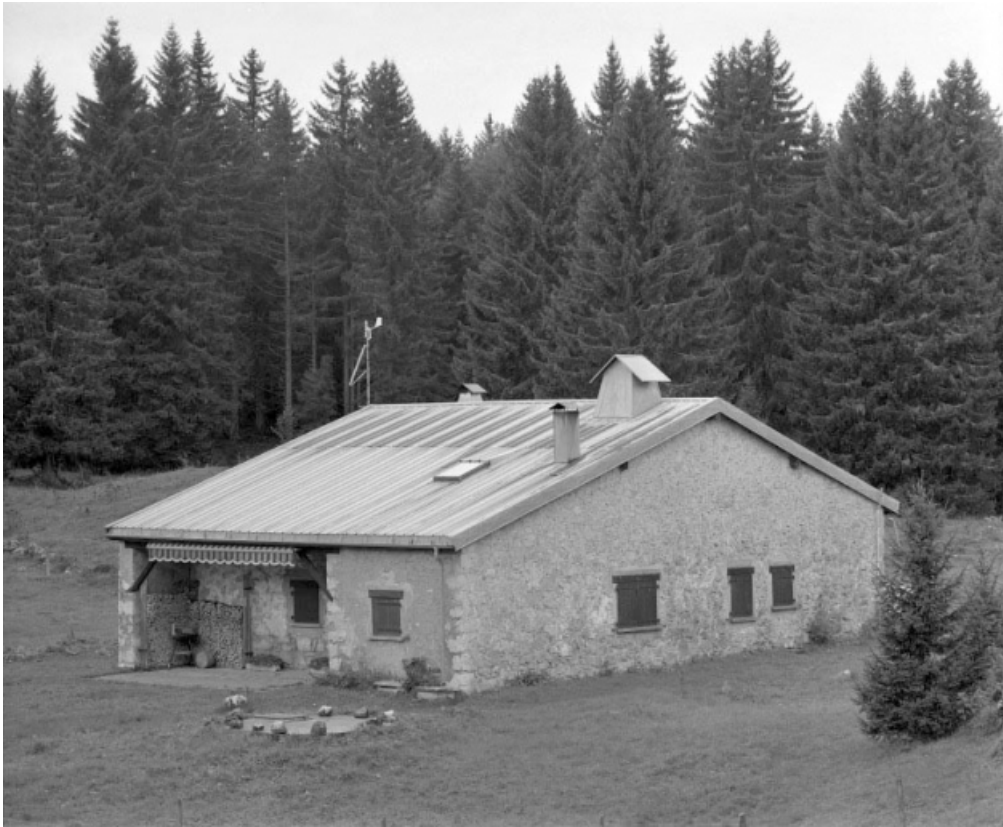
Façade antérieure et face droite.
