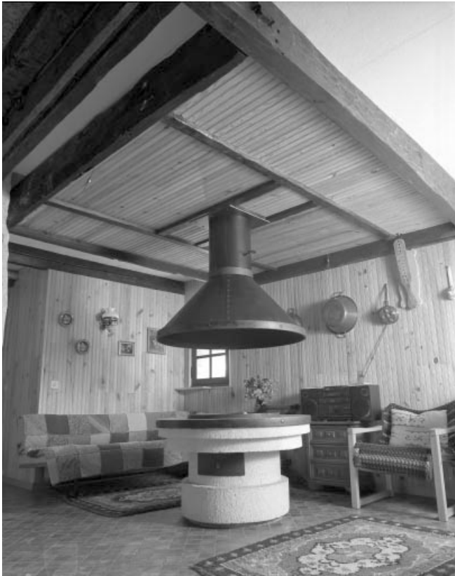
Le départ de la cheminée en bois au rez-de-chaussée.
