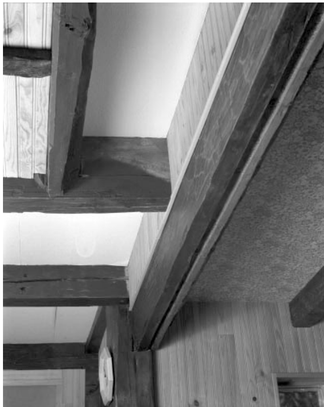
Détail de la rainure de la poutre dans laquelle venait se loger les planches de la cloison en bois, entre la cuisine et la grange. 39, Les Moussières, lieudit : au Montechoux
