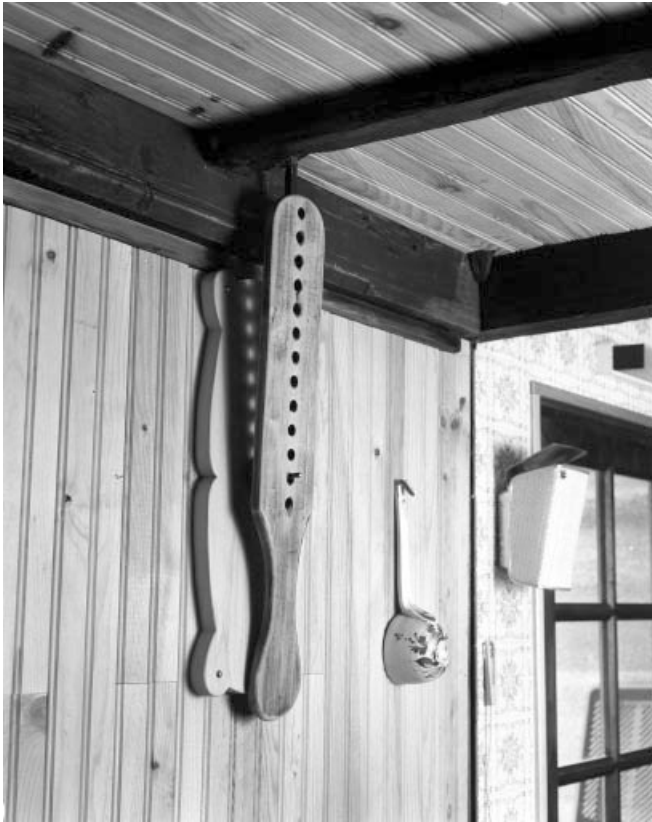
Détail de l'instrument en bois permettant d'ouvrir plus ou moins les volets fermant la cheminée en bois.
