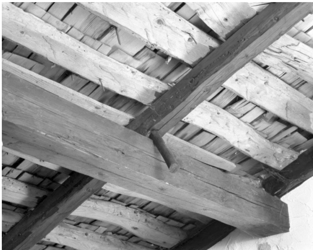
Détail d'une cheville en bois empêchant les chevrons de glisser.
