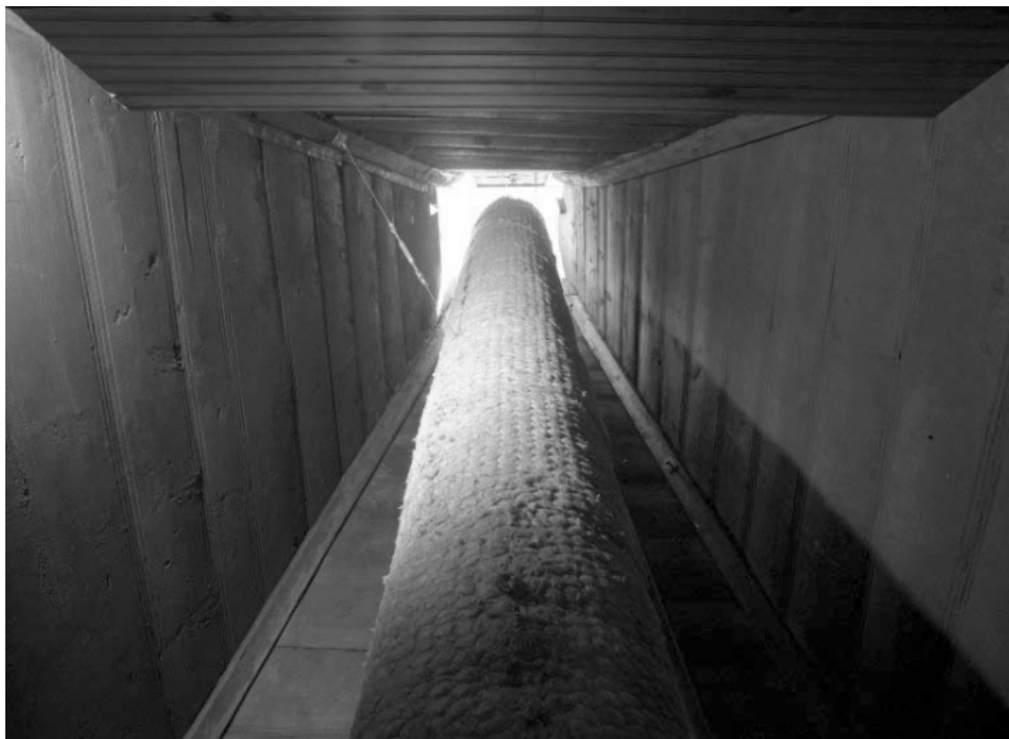
Intérieur du conduit de la cheminée en bois, un nouveau conduit isolé a été ajouté pour la cheminée actuelle. 39, Les Moussières, lieudit : au Montechoux
