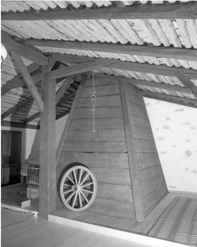
La cheminée en bois dans sa partie située dans la grange haute.
