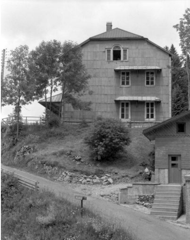
Face droite depuis le Chemin Départemental 25. 39, Les Moussières
