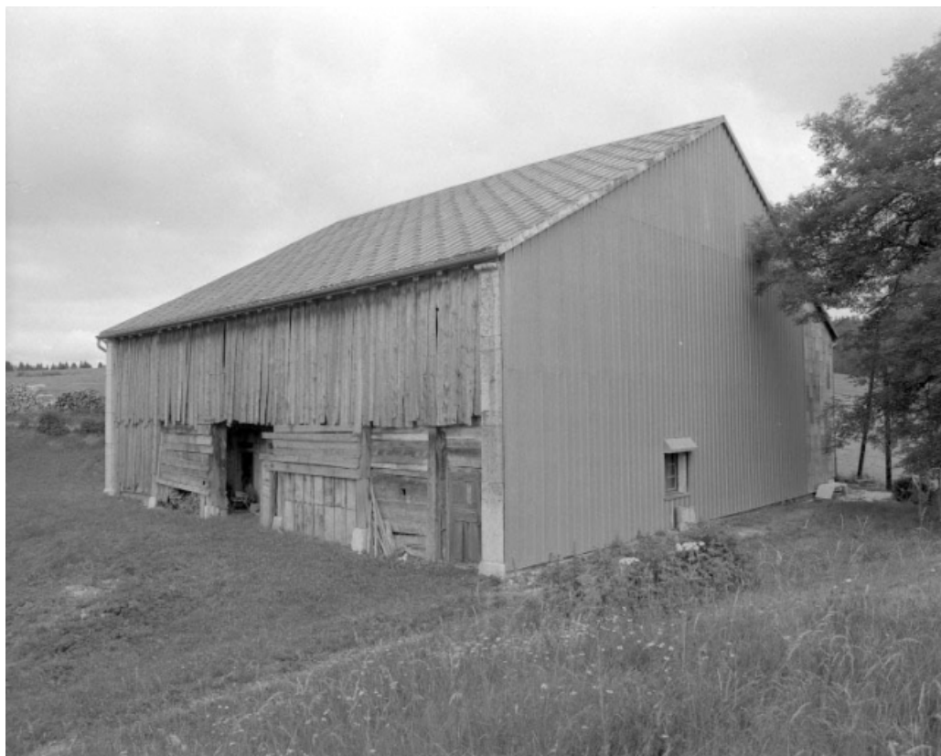
Façade postérieure et face gauche recouverte d'un essentage métallique.
