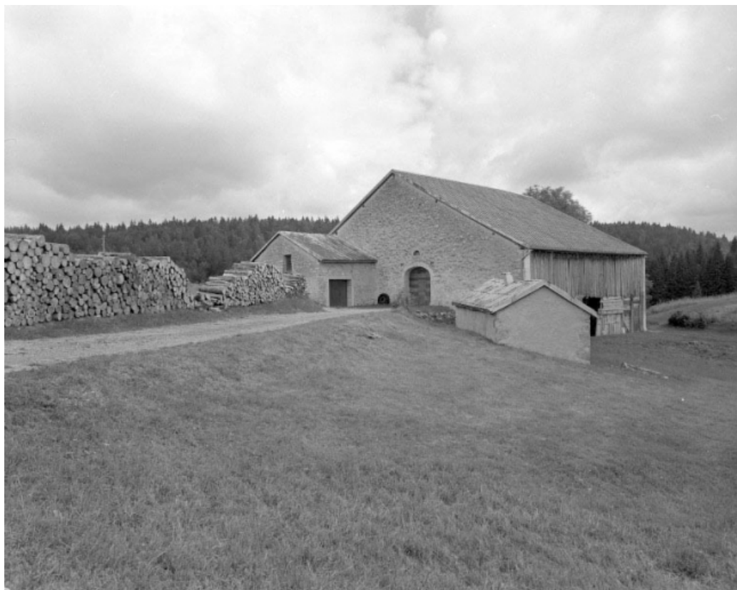
Face droite et façade postérieure avec, au premier plan, le fournil.
