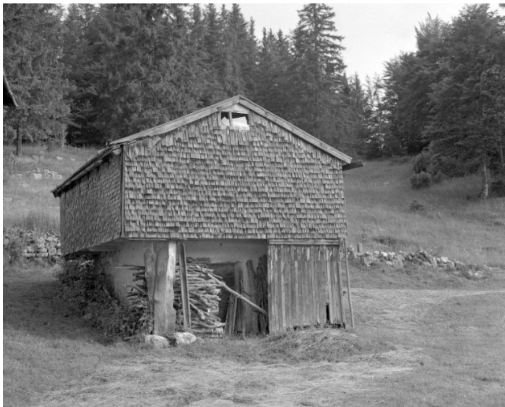
La resserre avec un accès en soubassement.
