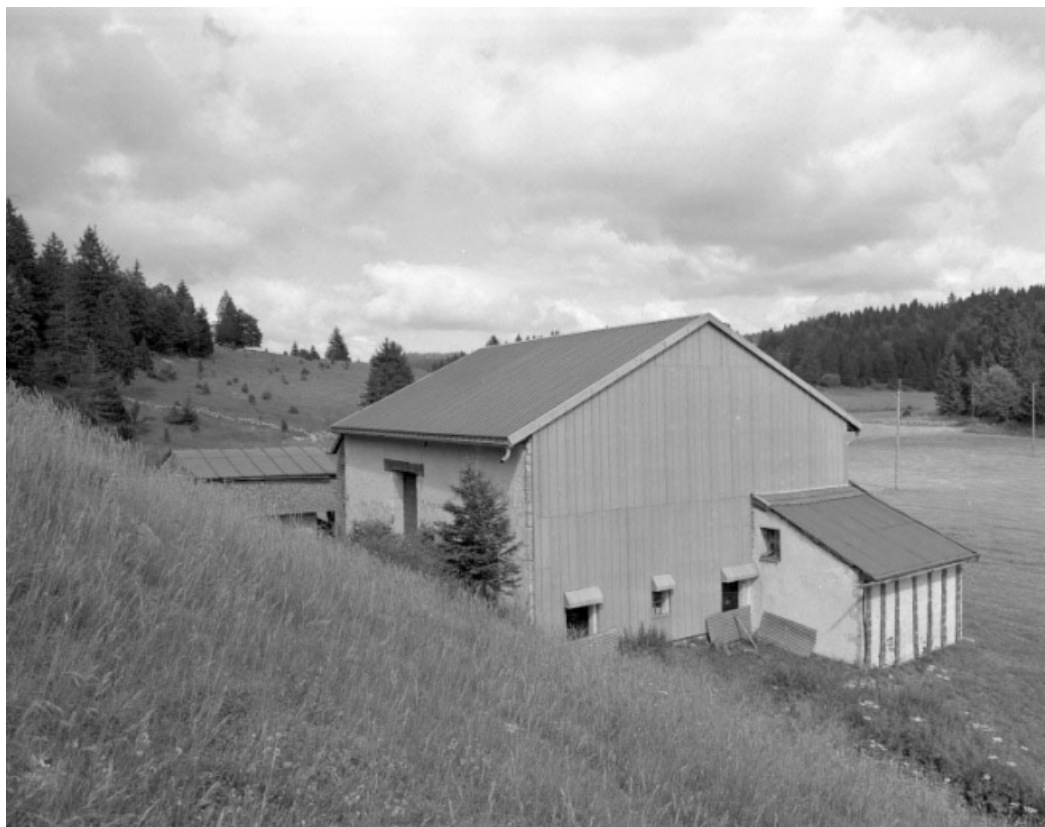
Face gauche recouverte d'un essentage de tôle et façade postérieure.
