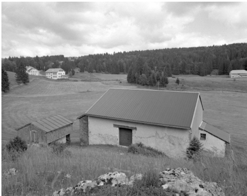
Façade postérieure avec resserre sur la gauche.
