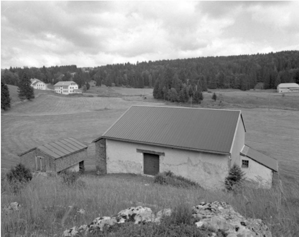
Façade postérieure avec resserre sur la gauche.
