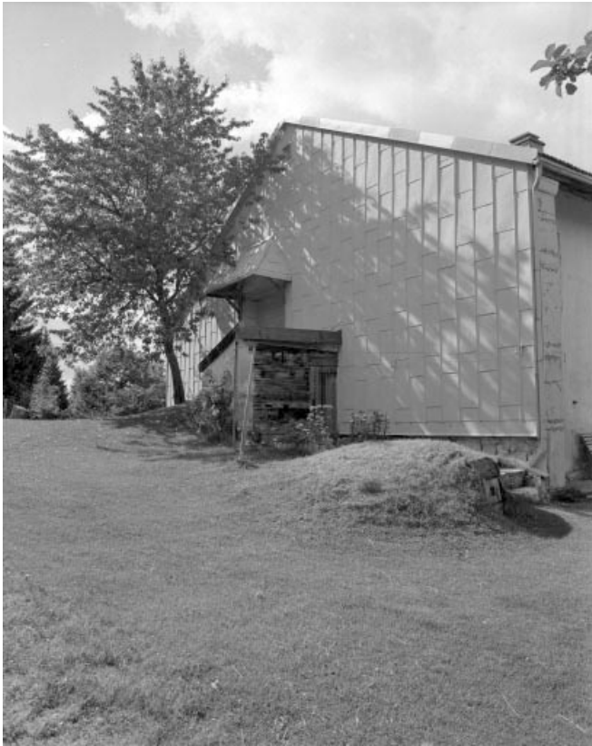
Face gauche recouverte d'un essentage de zinc.
