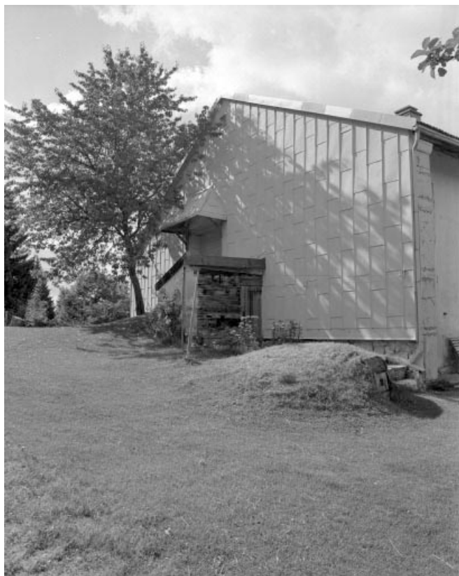
Face gauche recouverte d'un essentage de zinc.
