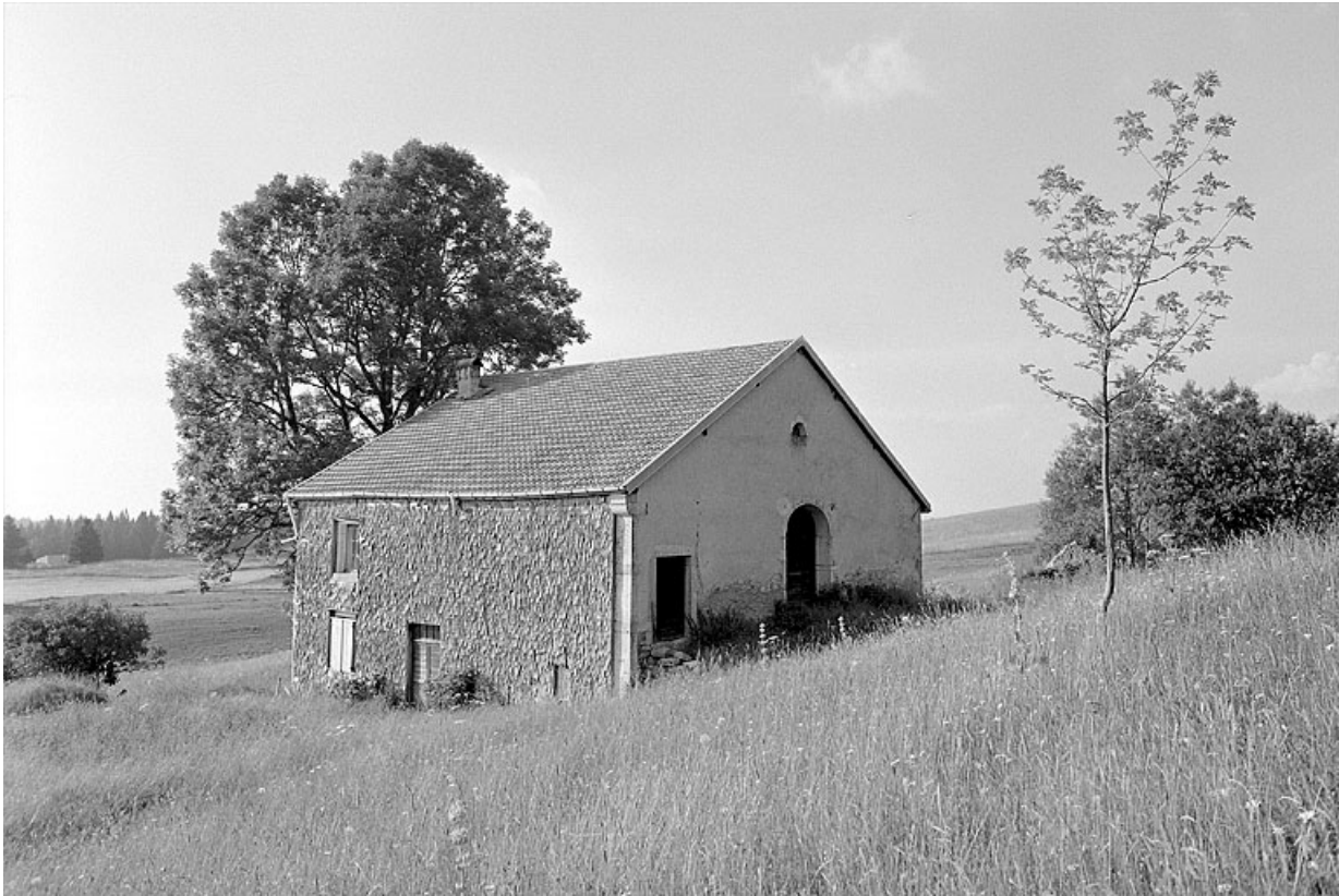
Façade antérieure et face droite.
