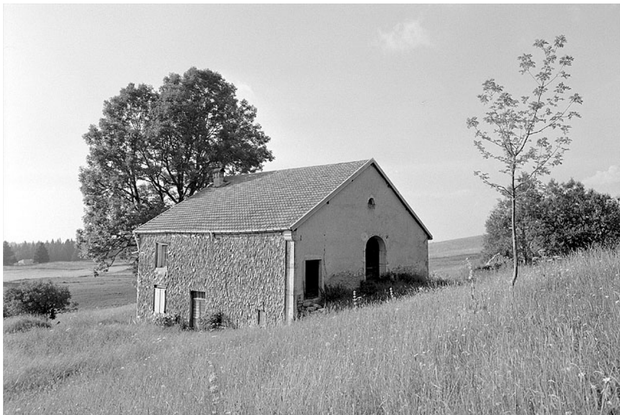
Façade antérieure et face droite.
