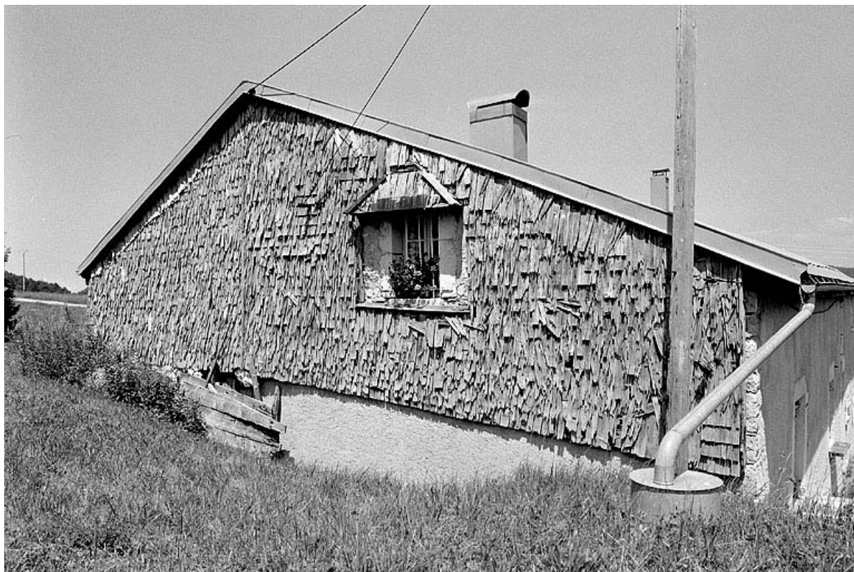
Face gauche couverte d'un essentage de tavaillons.
