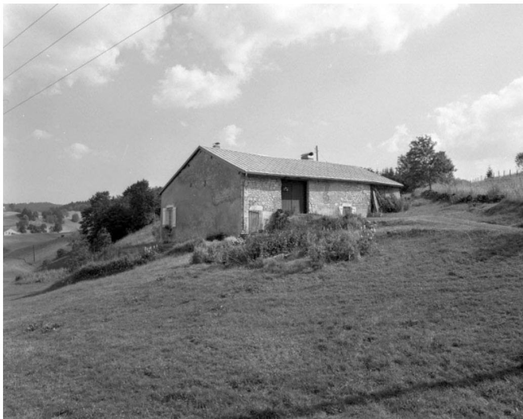
Face droite et façade postérieure.
