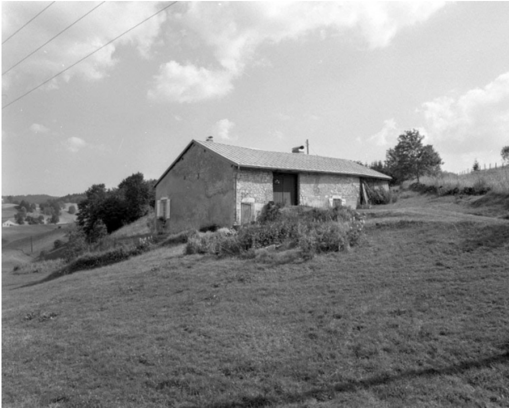
Face droite et façade postérieure.
