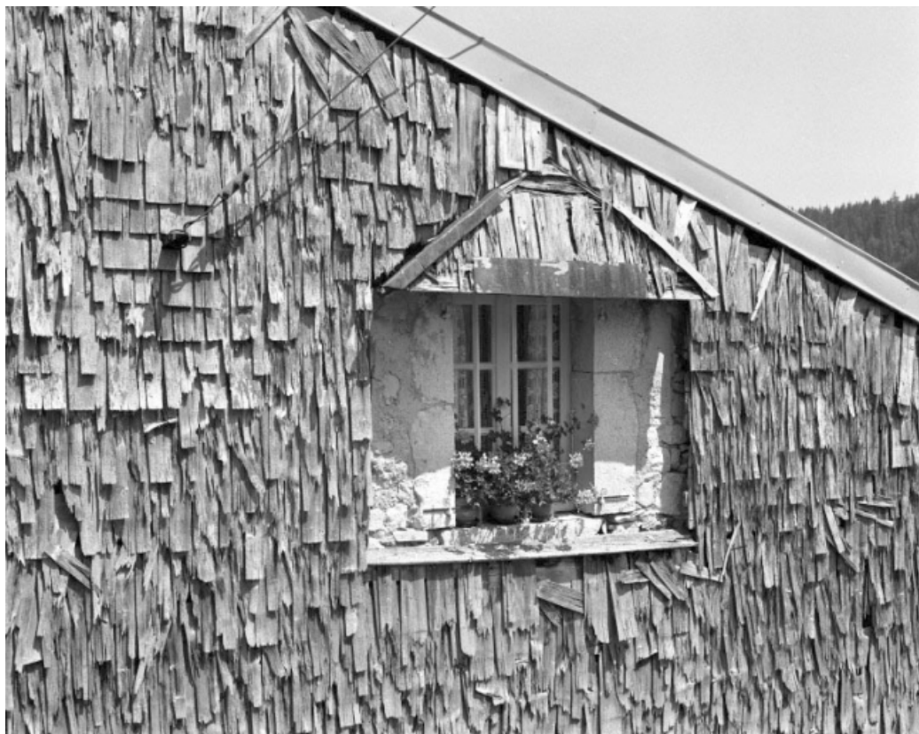
La fenêtre de la face gauche.
