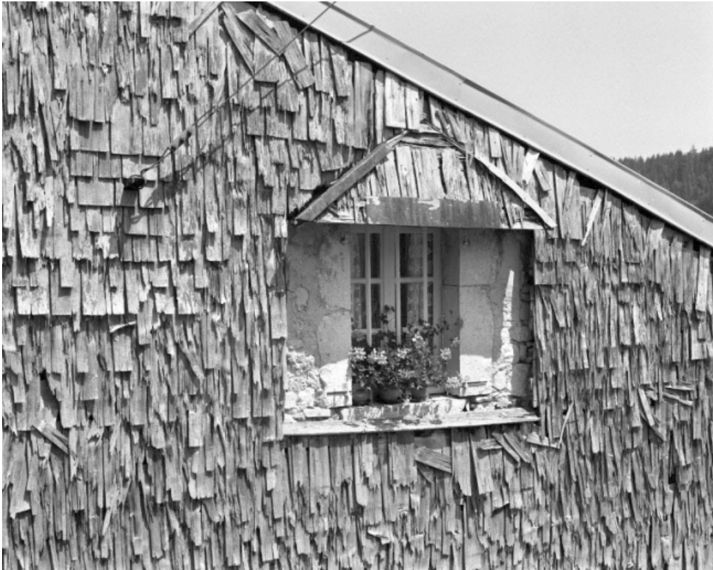
La fenêtre de la face gauche.
