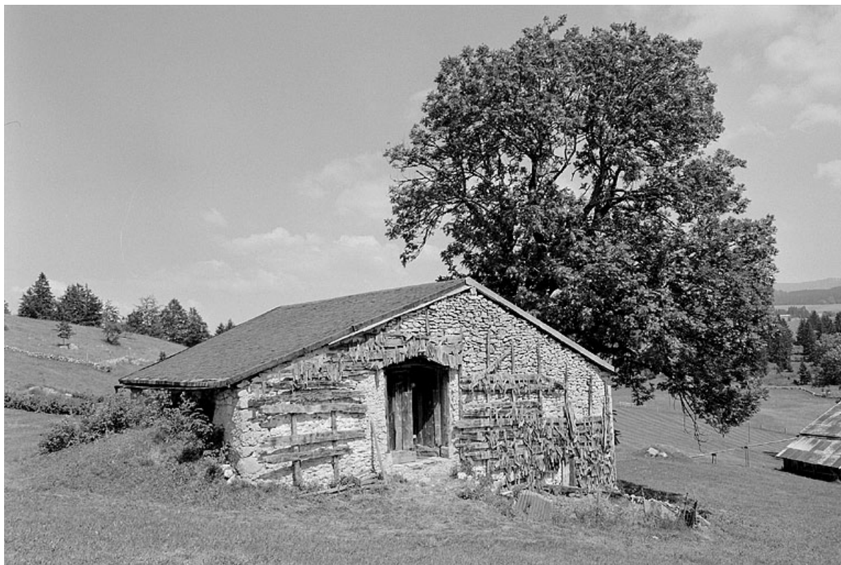
Face gauche avec les vestiges d'un essentage de tavaillons.
