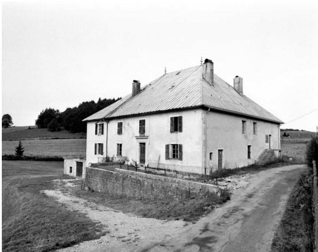
Façade antérieure vue de trois quarts.
