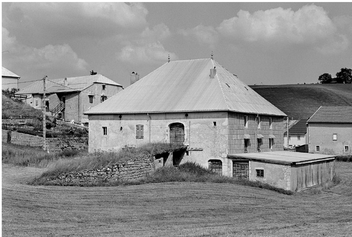
Façade postérieure et pignon couvert d'un essentage de zinc.
