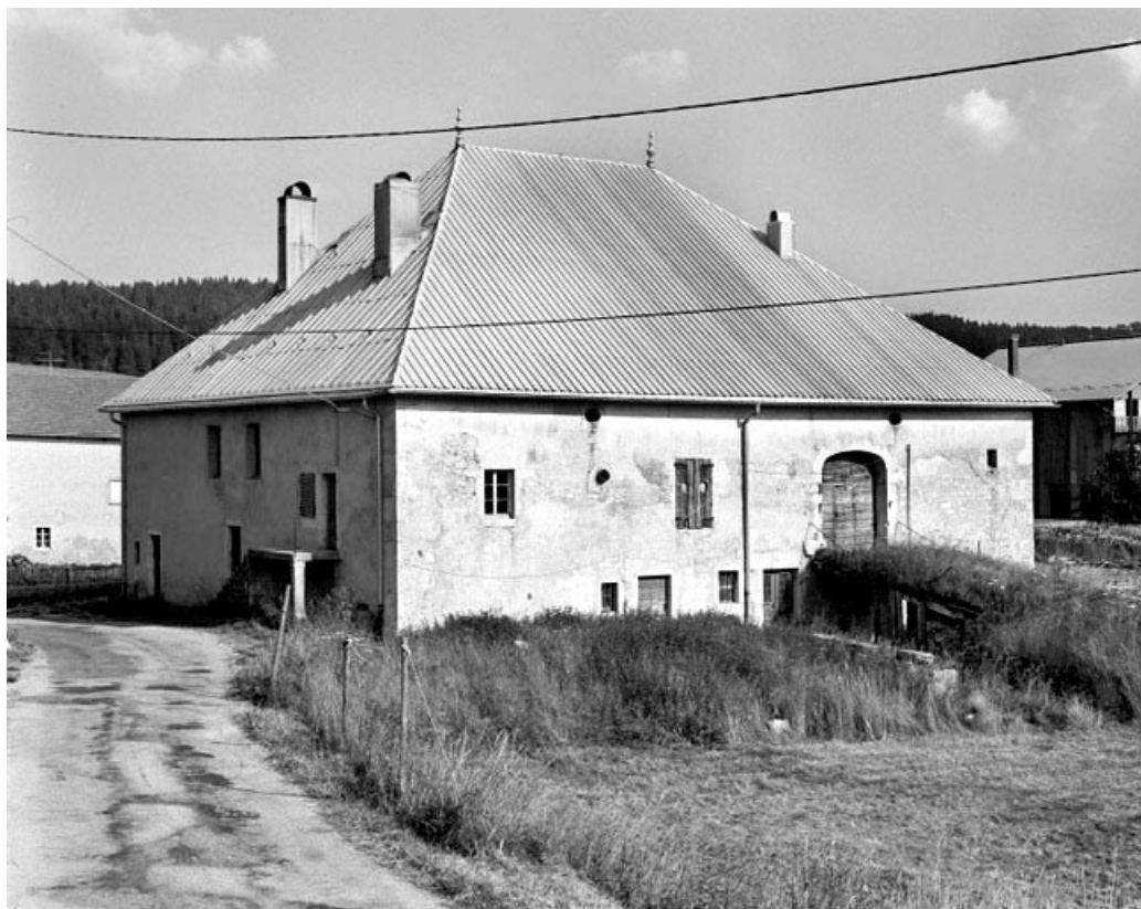
Façade postérieure avec accès aux parties agricoles.
