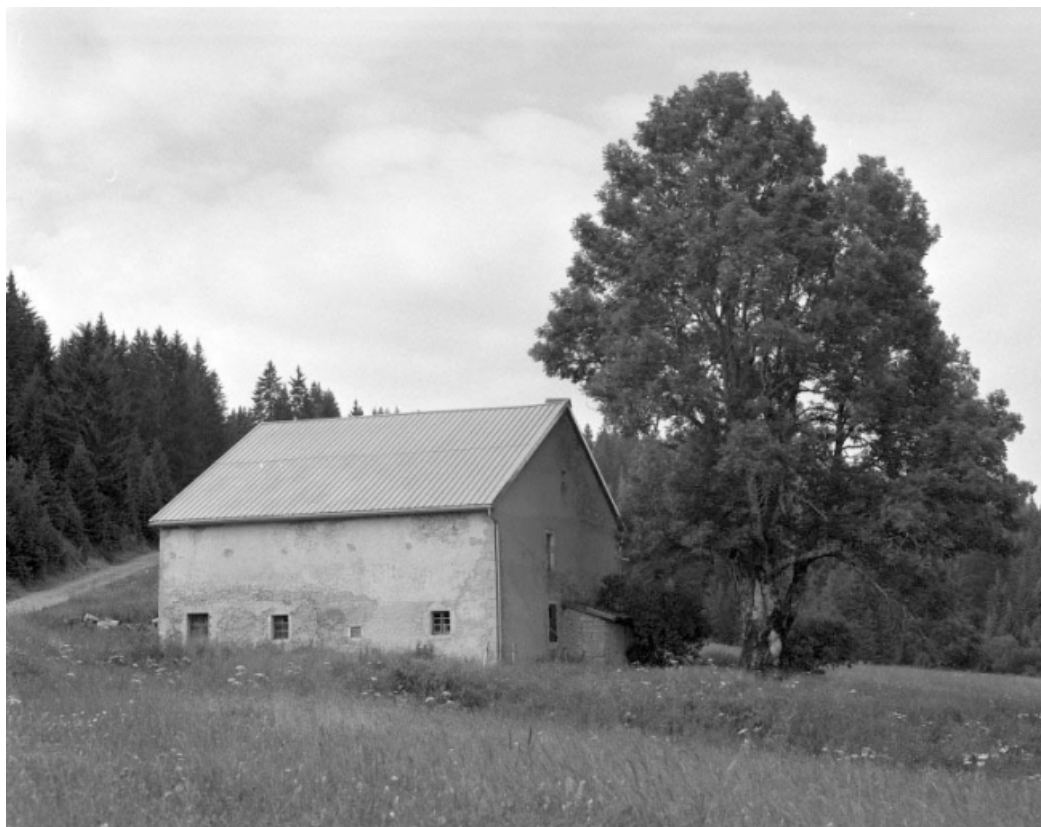
Façade postérieure et face gauche avec four en appentis.
