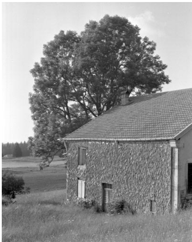
Façade antérieure avec essentage de tavillons.
