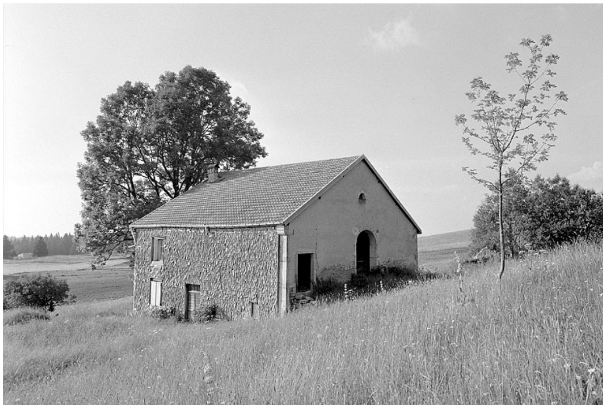
Façade antérieure et face droite.
