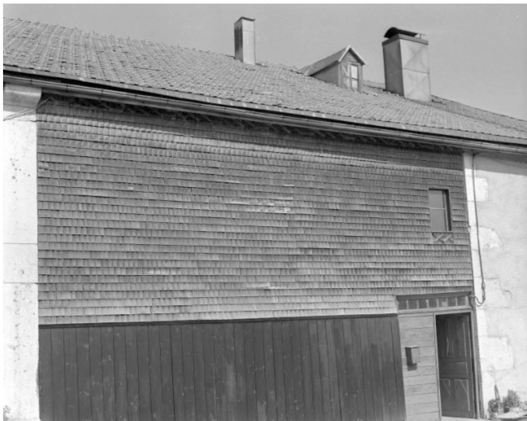
Détail de l'essentage de tavaillons sur la façade antérieure.
