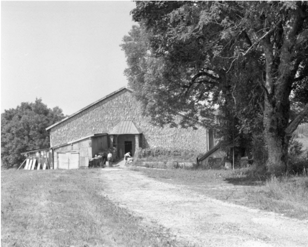
Face gauche couverte d'un essentage de tavaillons.
