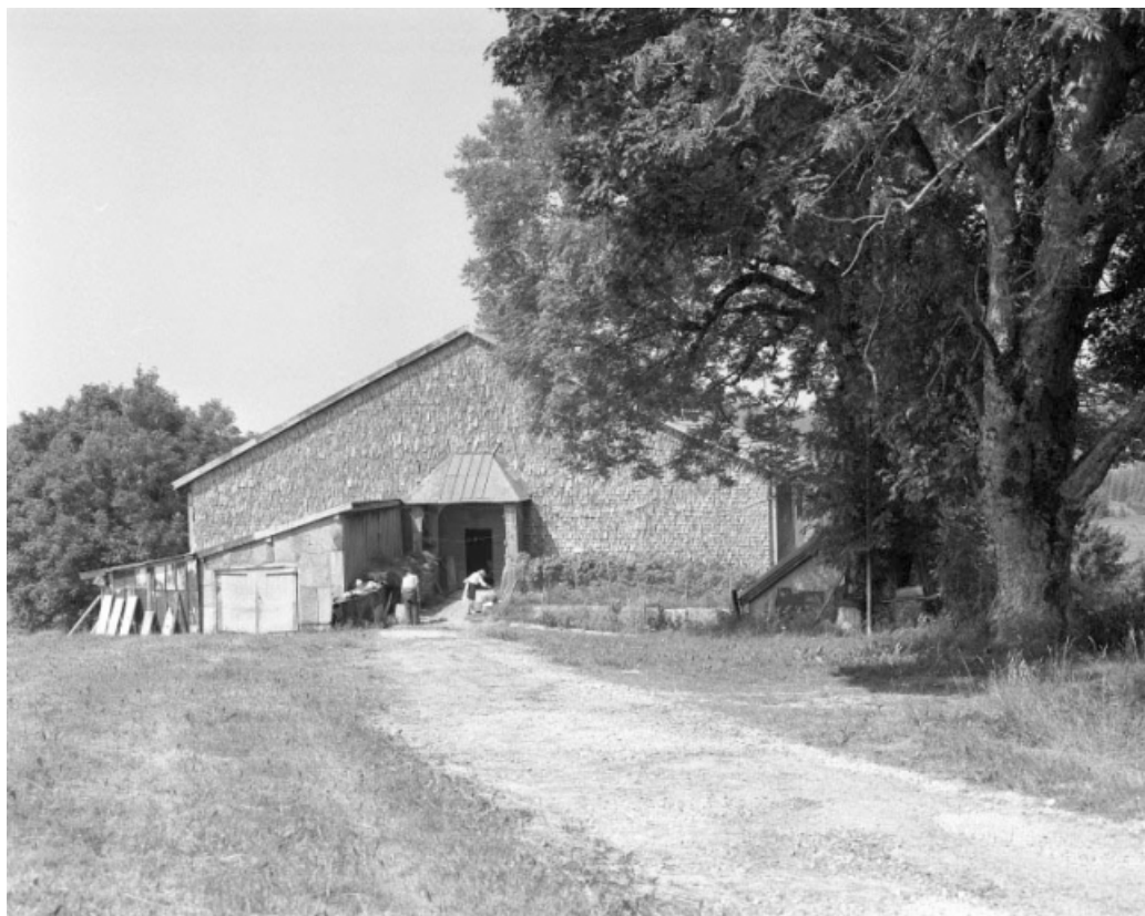
Face gauche couverte d'un essentage de tavaillons.
