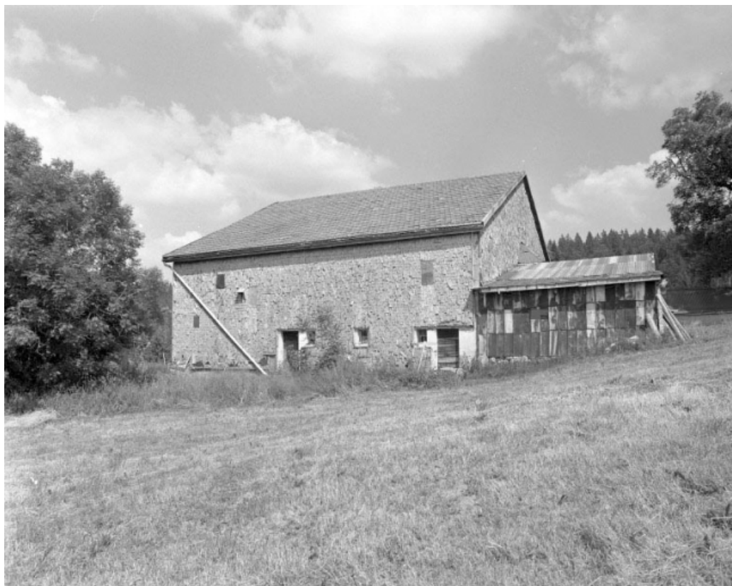
Façade postérieure couverte d'un essentage de tavaillons.
