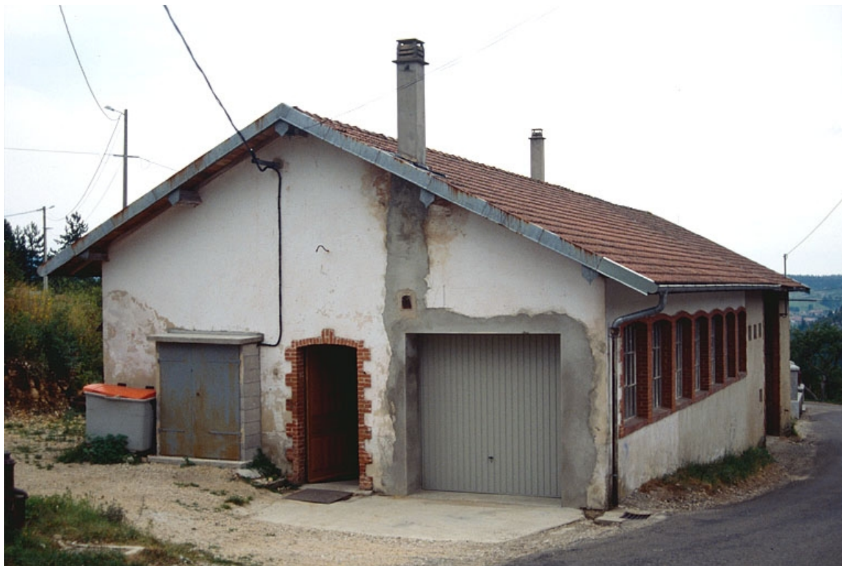
Façades antérieure et latérale droite.
