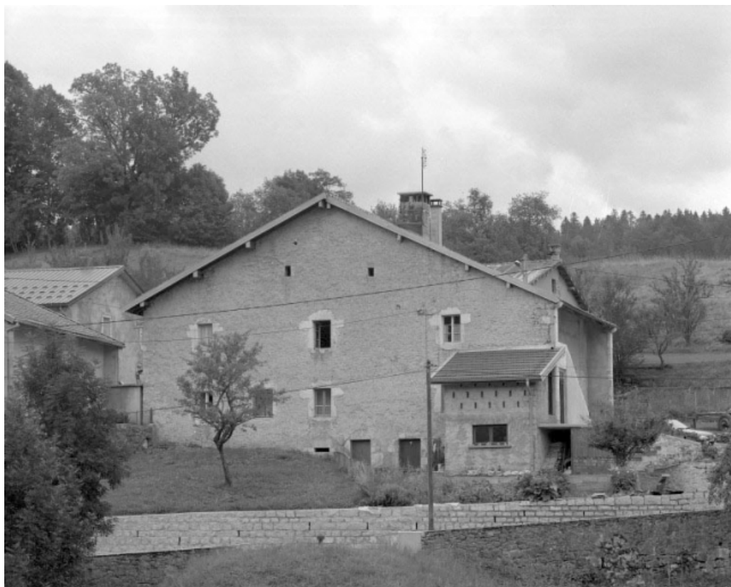
Face gauche et accès à l'étage de soubassement.
