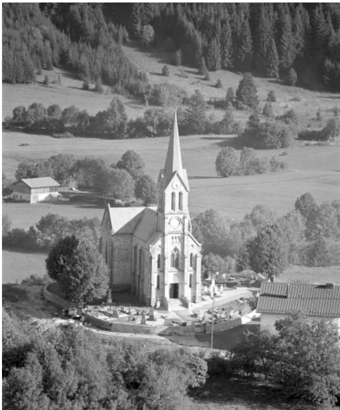
Extérieur : vue générale de la façade ouest, de trois quarts. 39, Choux
