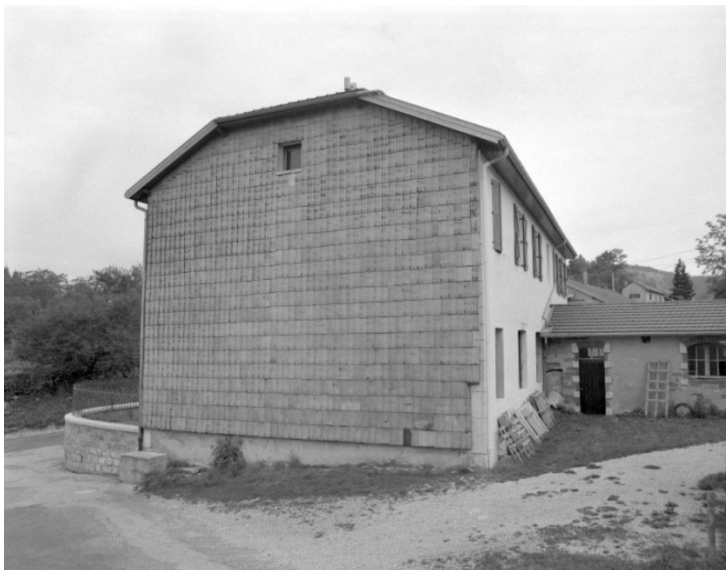
Face droite et préau sur la façade postérieure.
