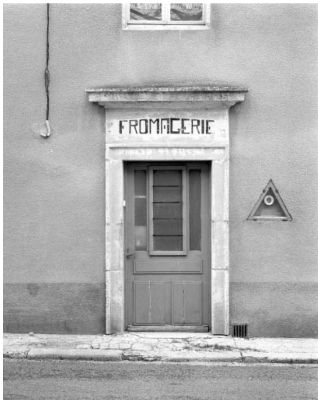
Porte d'entrée de la fromagerie.
