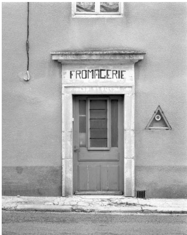
Porte d'entrée de la fromagerie.
