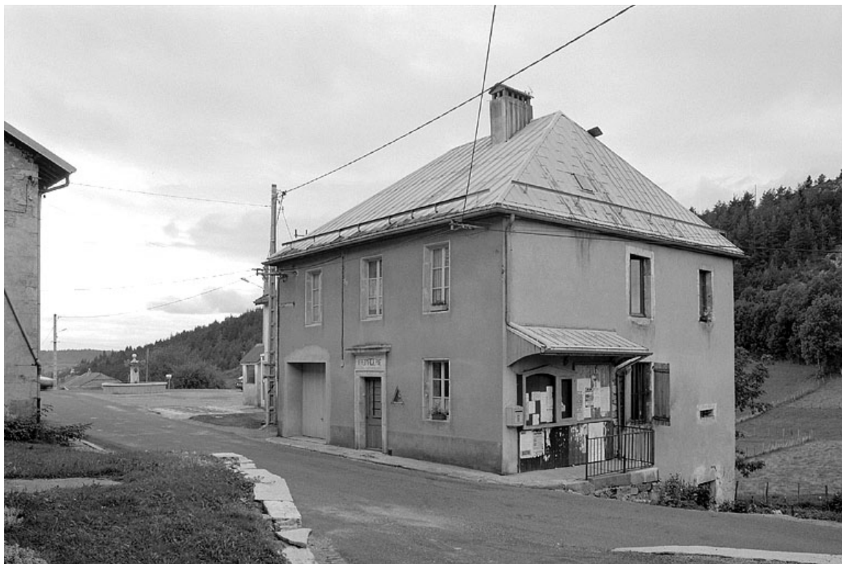
Façade antérieure et face latérale droite. 39, Choux
