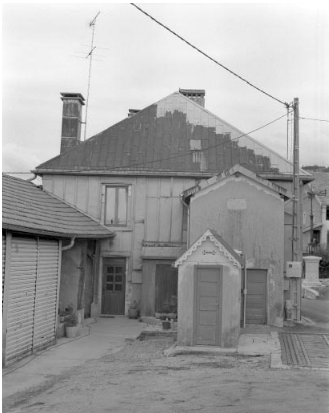
Face latérale gauche couverte d'un essentage en feuilles de zinc. 39, Choux
