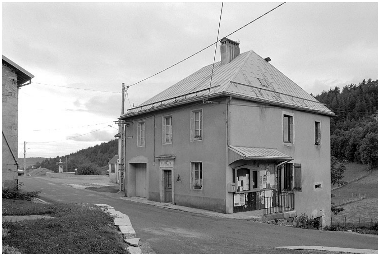
Façade antérieure et face latérale droite. 39, Choux
