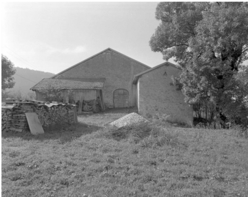
Face droite de la ferme avec ses extensions.
