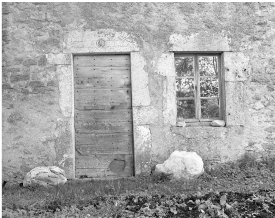
La porte d'accès à l'extension sur l'arrière de la ferme.
