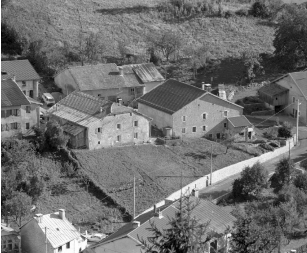
Vue depuis le haut, face gauche et façade postérieure. 39, Choux
