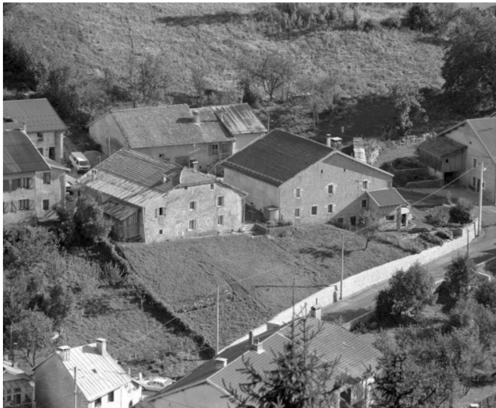
Vue depuis le haut, face gauche et façade postérieure.
